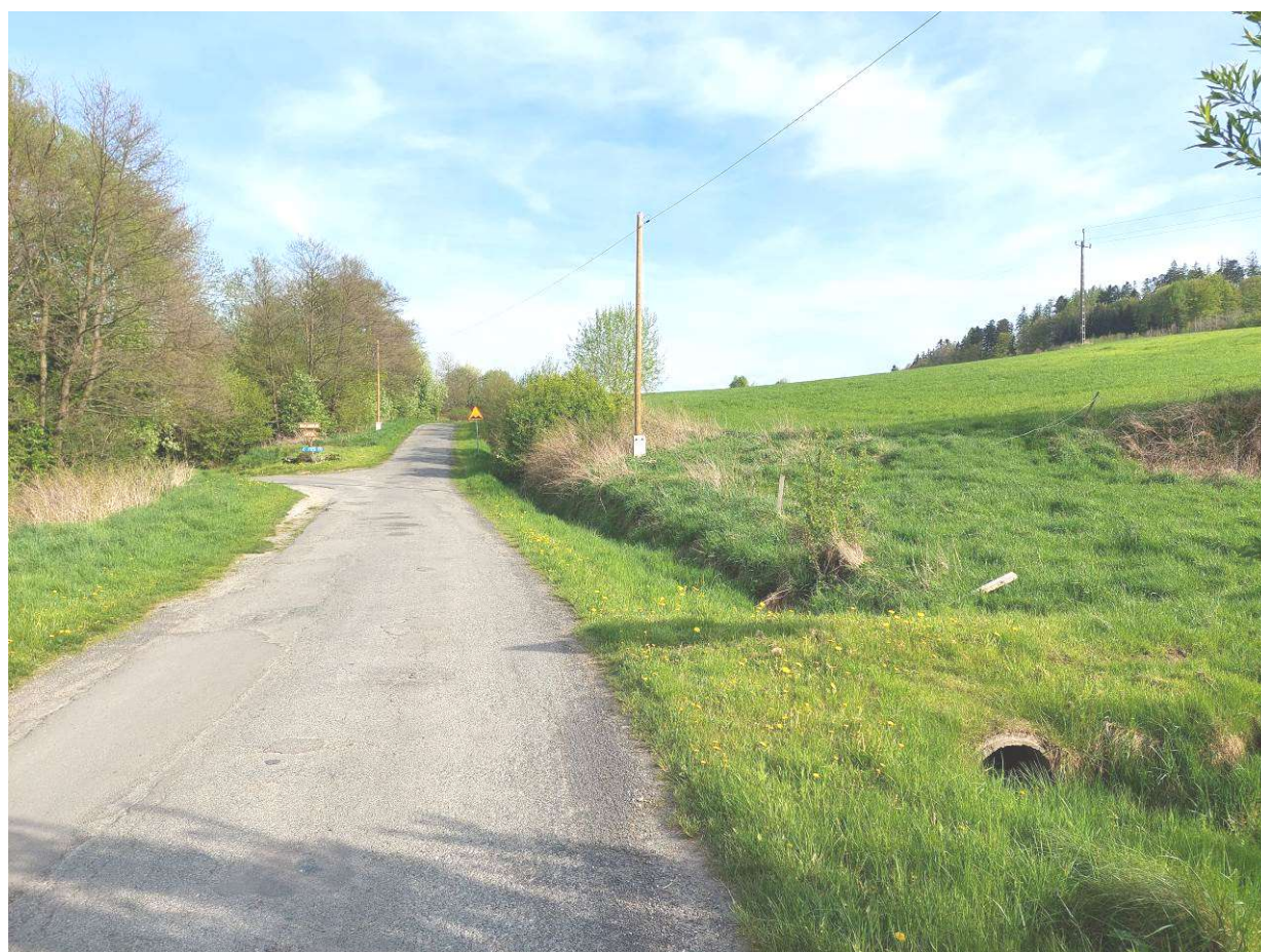
Zdjęcie nr 3. Odcinek końcowy - (km 0+950)
