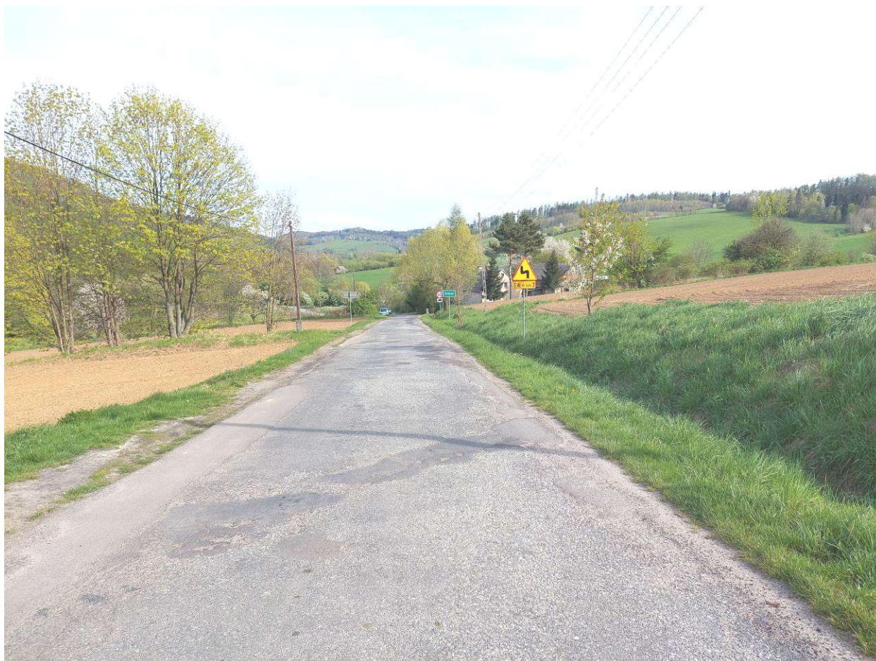
Zdjęcie nr 1. Początek odcinka (km 0+020)
