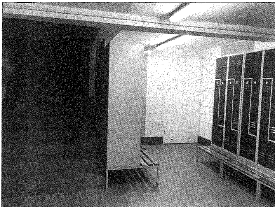
Klatka schodowa w piwnicy
