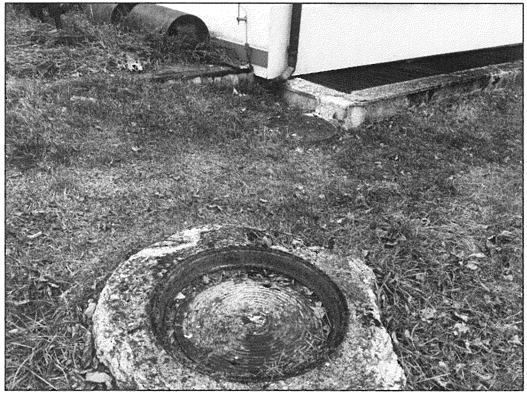
Widok ściany fundamentowej
