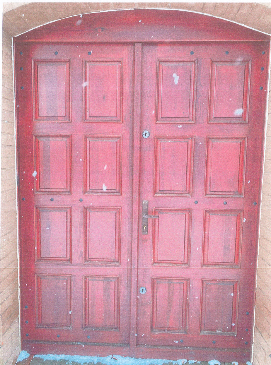
Widok na główne drzwi wejściowe do kaplicy.
