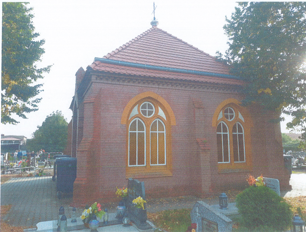
Widok na elewację boczną - północną
