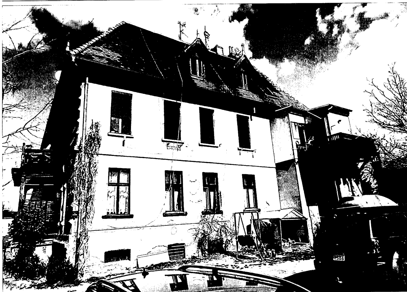
Fot. 8 Widok elewacji podwórzowej.
