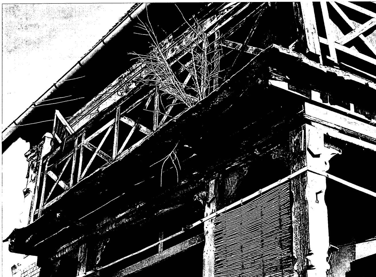
Fot. 11 Widok zniszczonej podłogi balkonu.
