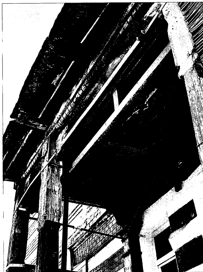
Fot. 11 Widok zniszczonej podłogi balkonu.
