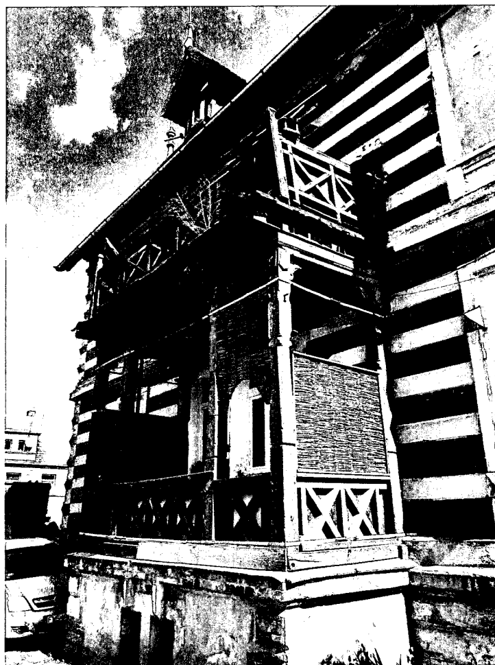
Fot. 10. Widok balkonu na elewacji zachodniej.
