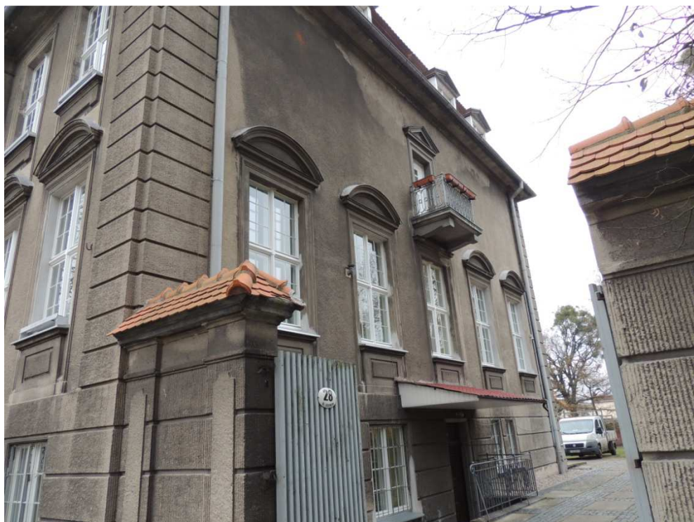
48. Elewacja od strony ul. Bema.
