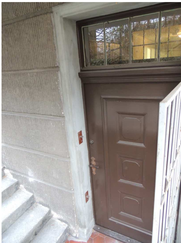
52. Drzwi do piwnicy, ościeże pokryte warstwą cementu.
