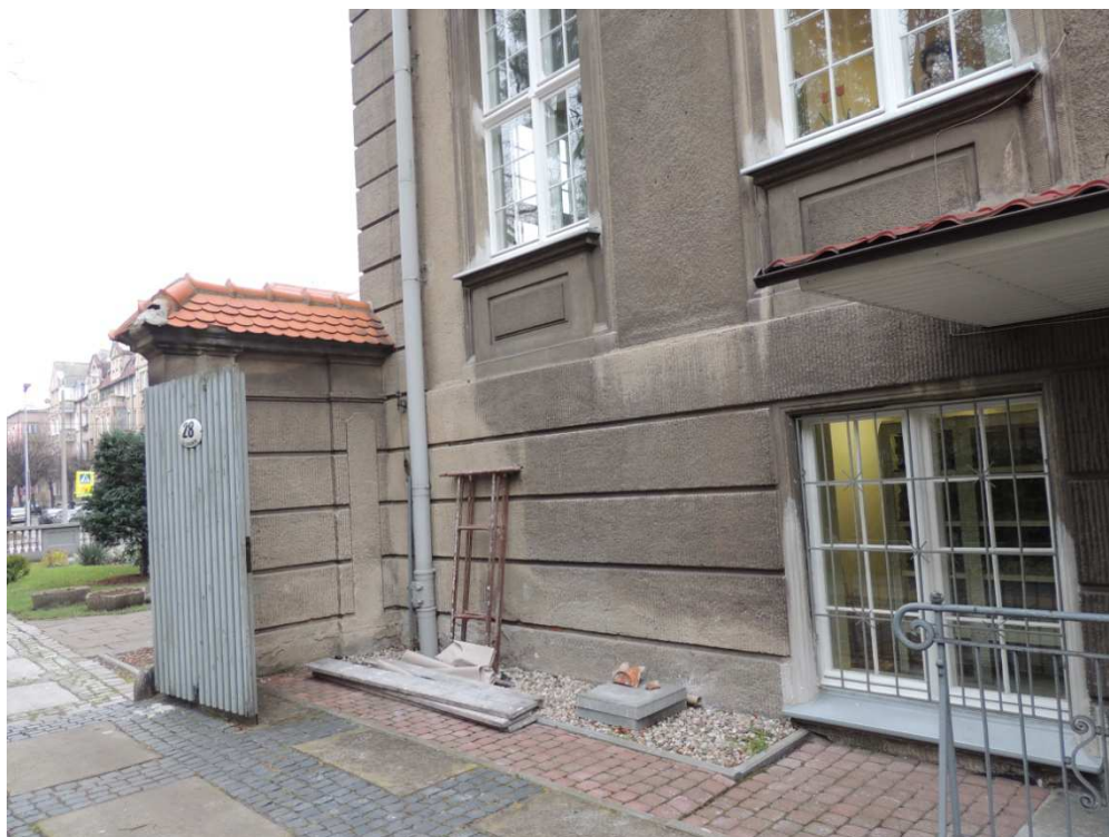
49. Elewacja od strony ul. Bema, styk z murkiem wjazdowym.
