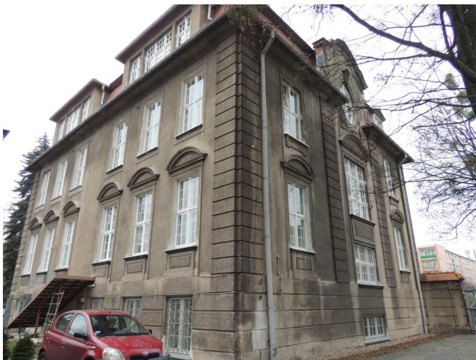
29. Elewacje ogrodowa i od ul. Armii Krajowej. Widoczne przepłukania elewacji i pasy czarnych nawarstwień.
