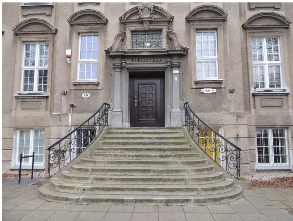
8. Portal i główne wejście do budynku.
