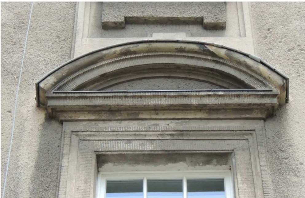
4. Naczótek okna na elewacji frontowej.
