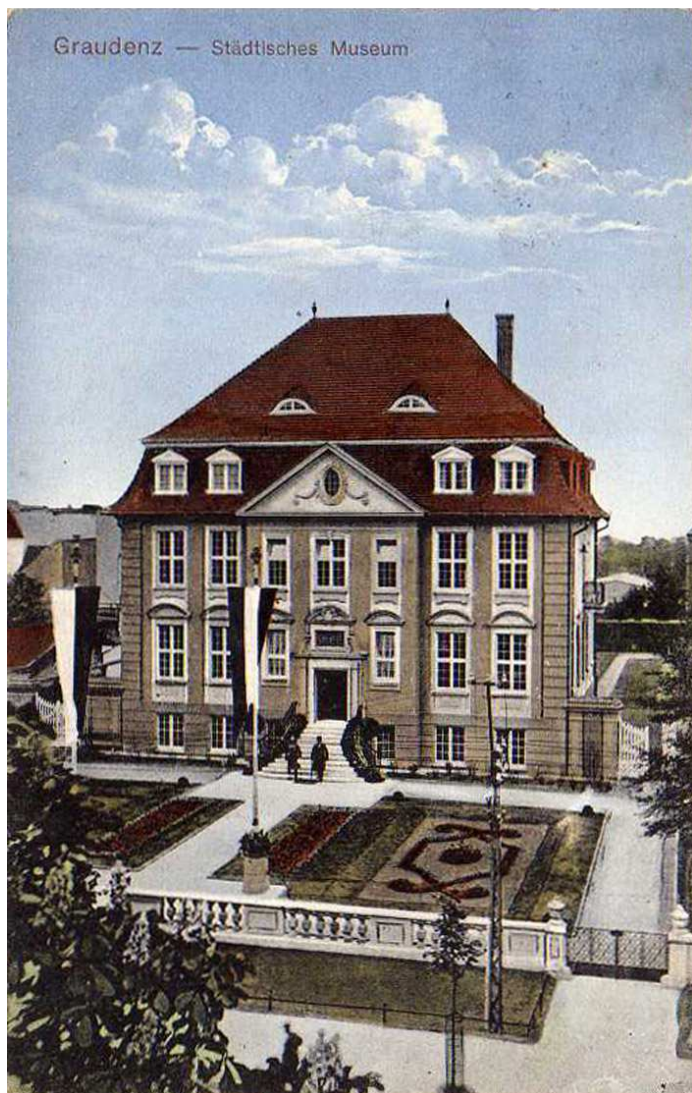
2. Fotografia datowana na 1911 rok. Widoczne odróżnienie kolorem pasów okiennych, elementów portalu i frontonu. Facjunki w białym kolorze i skrzydła bram. Trudno ocenić jak wyglądała elewacja boczna.
