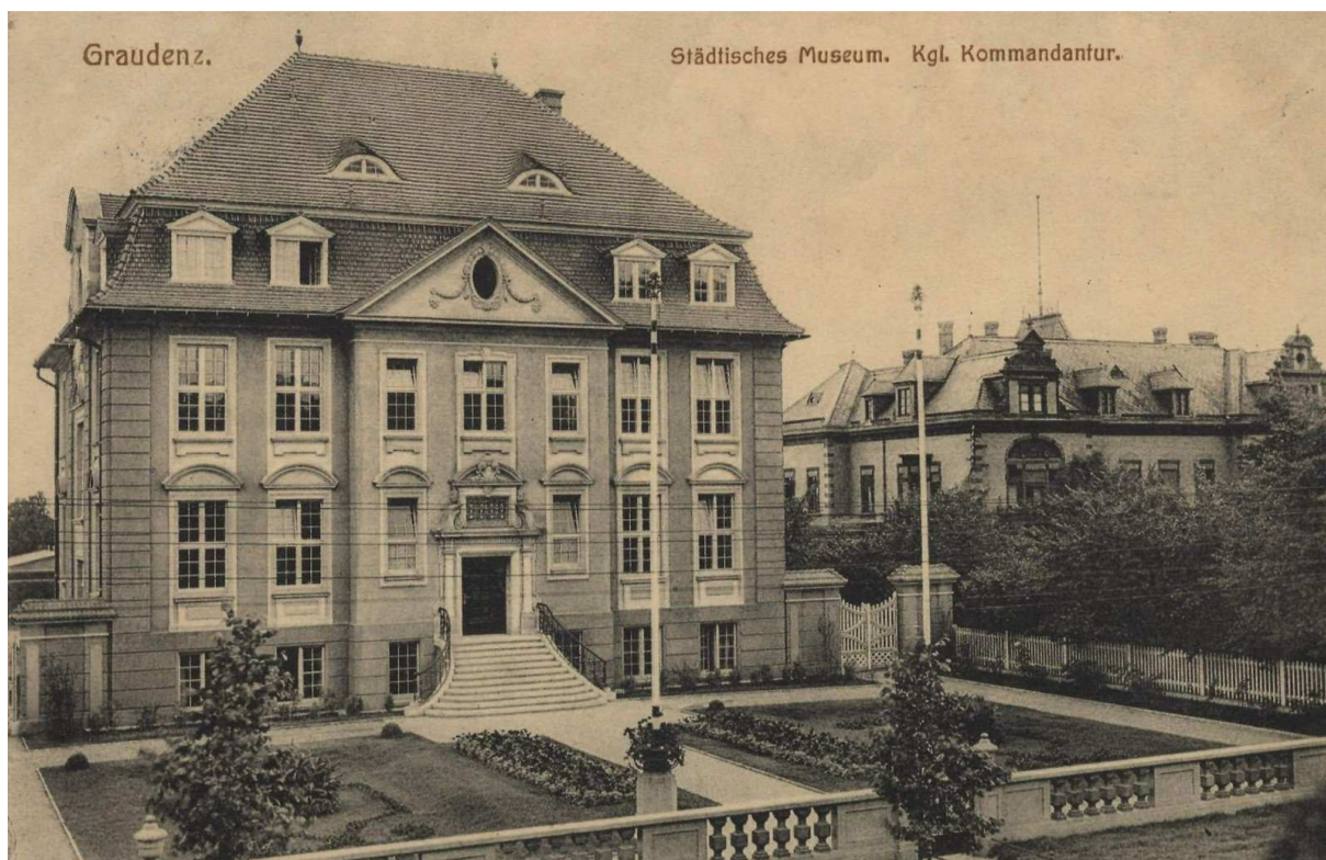
3. Fotografia datowana na 1912 rok. Widoczne wymalowania detalu architektonicznego.
