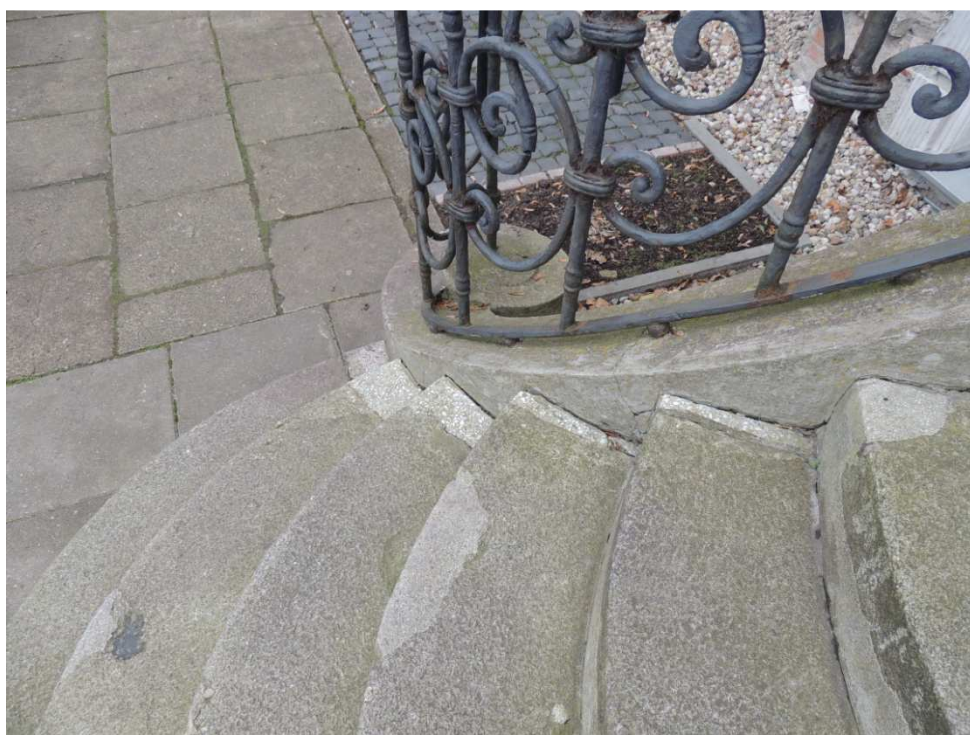
18. Wypełnienia lastrikowe w partii schodów.
