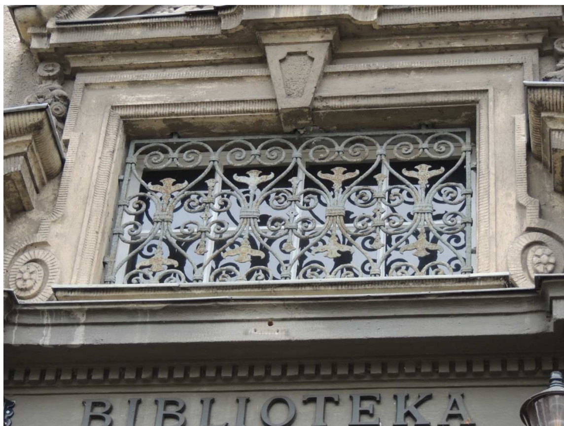
12. Górna część portalu, krata.
