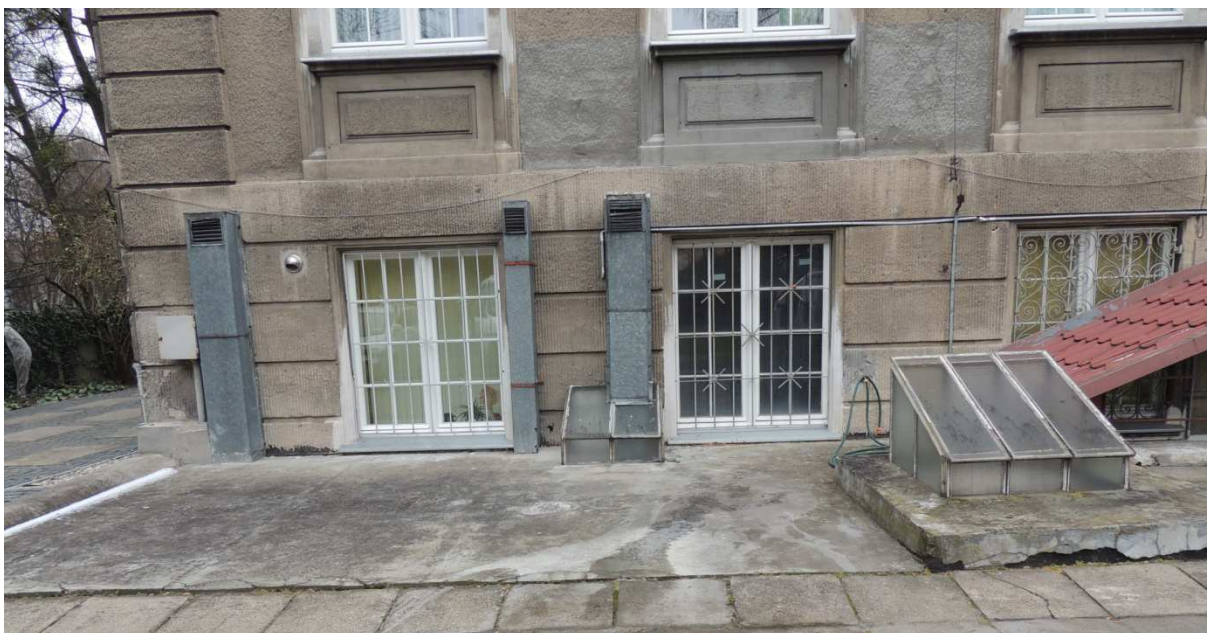
45. Elewacja ogrodowa, pas przyziemia.
