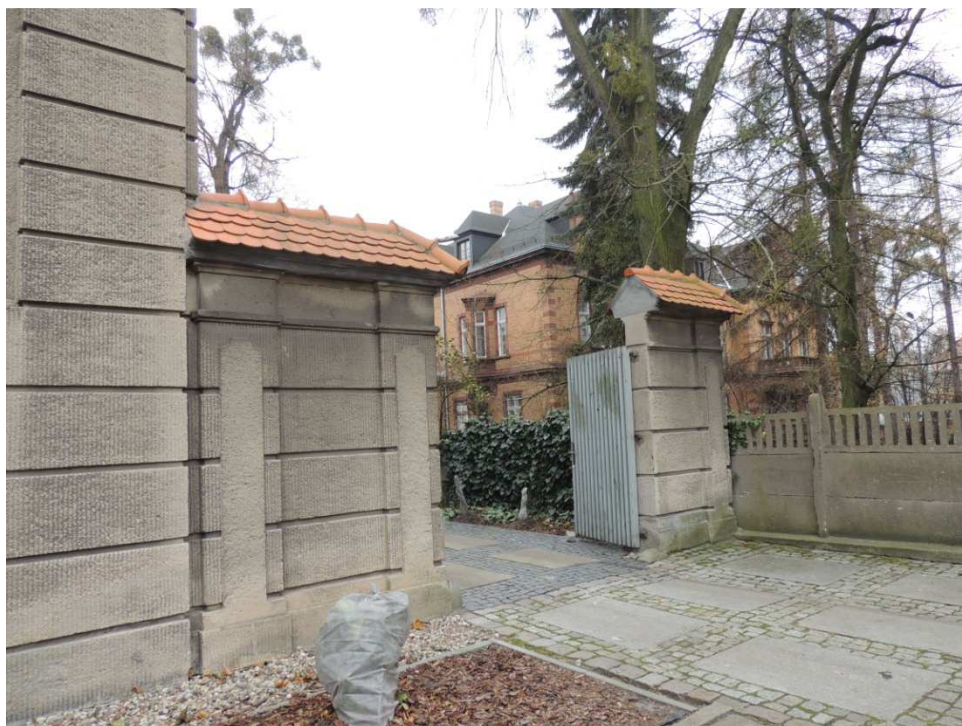
23. Murek wjazdowy lewy, skrzydło bramy. Front.
