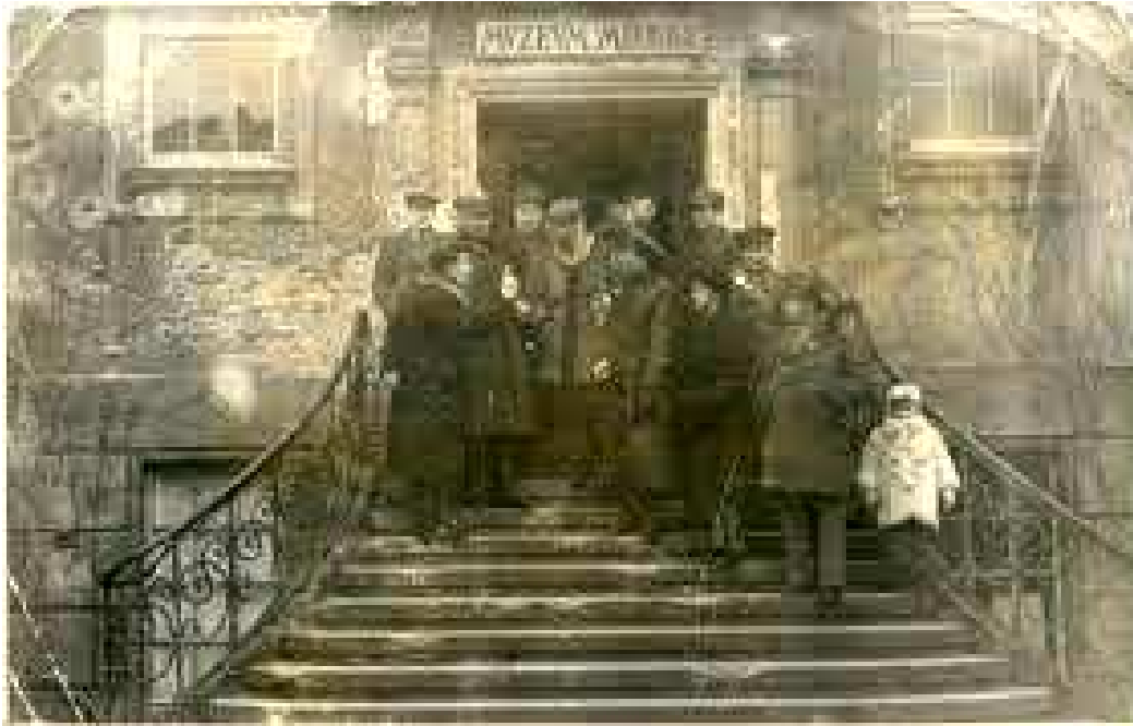
6. Lata 30-te XX wieku, widoczne zniszczenia wojenne elewacji i ubytki krawędzi stopni granitowych. Nie widać natomiast rozsunięcia stopni obecnie wypełnionych lastrikiem. Nad wejściem napis: MVZEVN MIEJSKIE.
