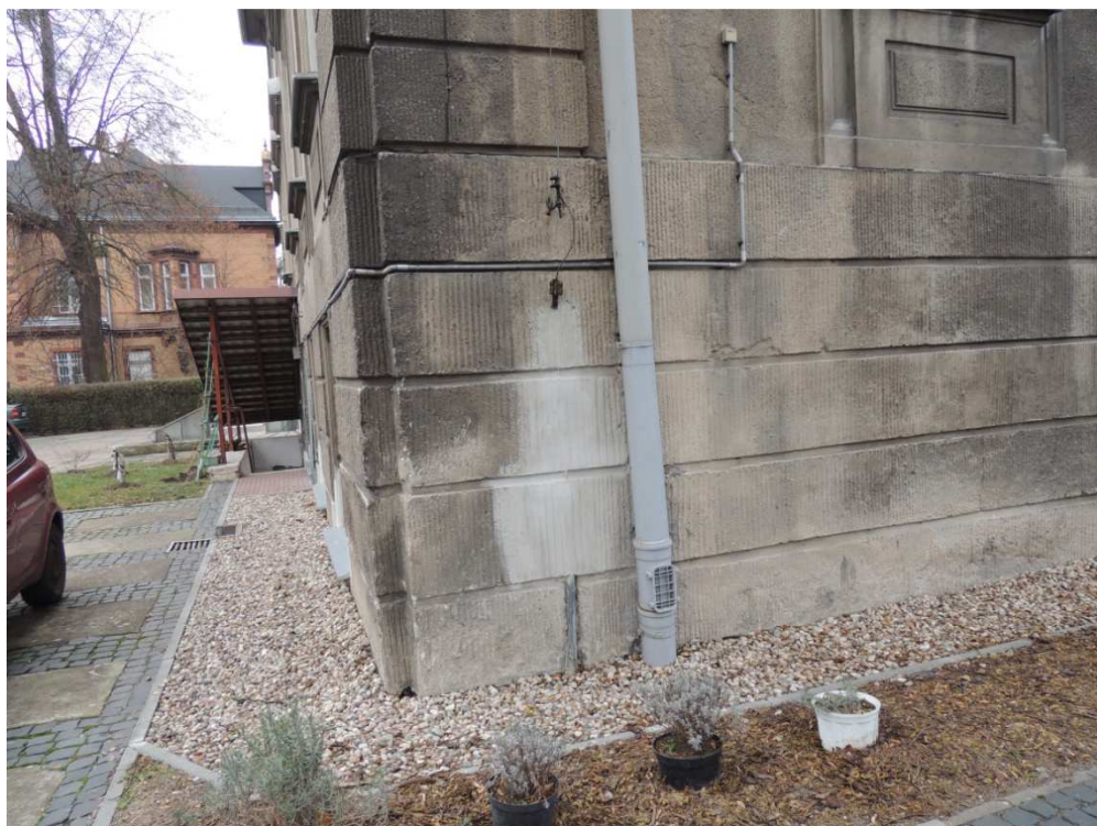
30. Narożnik elewacji z fot. 29.
