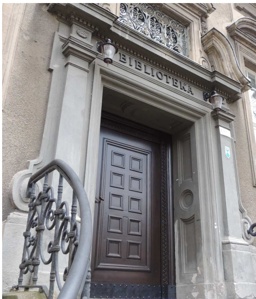
13. Dolna część portalu pokryta warstwą zaprawy cementowej.
