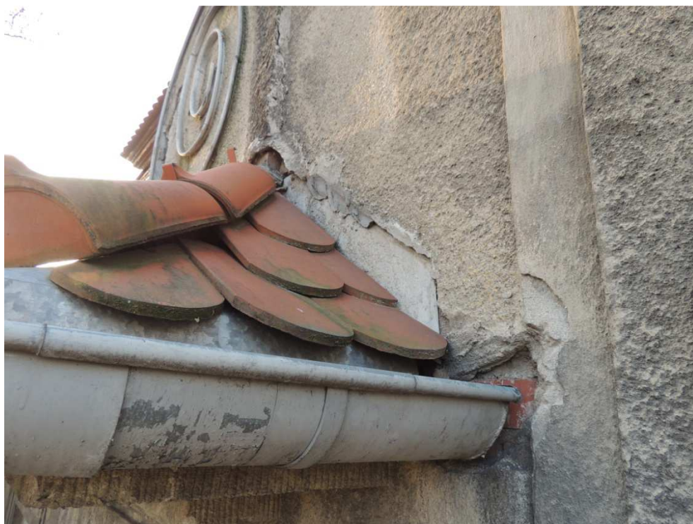
40. Zniszczenia tynków.
