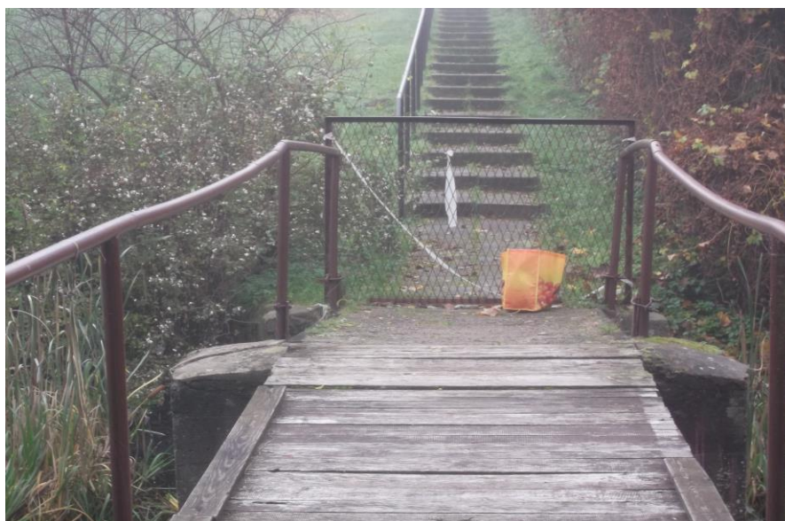
Fot. 5. Widok dojścia do kładki i początku pomostu P-1 kładki po stronie ulicy. Kładka zamknięta dla ruchu. Widok po stronie dojścia, przyczółka i filara oraz żelbetowego pomostu P-1 a na pierwszym planie nawierzchni drewnianej głównego pomostu P-2 z widocznym ubytkiem deski krawężnikowej poboczy nawierzchni. Istniejące, nienormatywne balustrady z rur stalowych, powyginane i wystające około 10 cm poza obrys pomostu, nie stanowią wymaganego zabezpieczenia dla ruchu.
