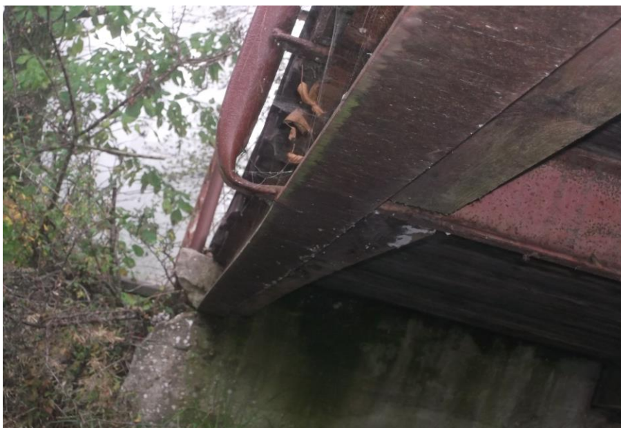
Fot.16. Widok posadowienia pomostu P-2 na przyczółku po stronie kościoła. Stalowa konstrukcja pomostu z dwóch dwuteowników 200 mm stężanych poprzecznie kształtownikami 160 mm posadowiona, bez łożyskowania, na uszkodzonym, spękanym i pozbawionym skrzydeł ocze pie przyczółka. Betonu korpusu przyczółka niskiej klasy C 8/10, C 12/15 i pozaklasowy w miejscach uszkodzeń.
