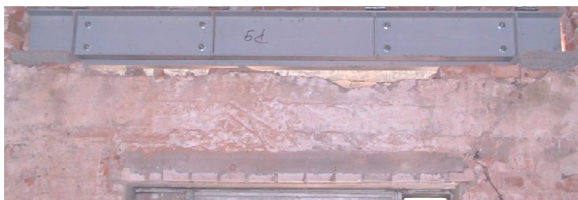
Fot. nr 1 Przykładowo wykonane nadproże stalowe
