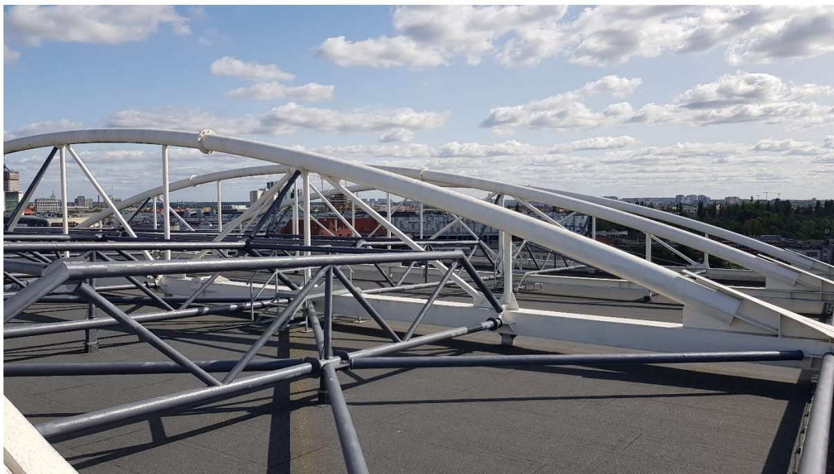
Rysunek 5 - Widok konstrukcji dachu osie 7-3
