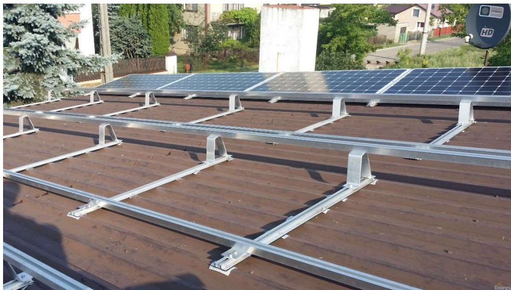
Rysunek 13 – Wizualizacja systemu inwazyjnego dla montażu paneli fotowoltaicznych firmy Energy5. Źródło: https://www.energy5.pl/realizacje/realizacje-konstrukcje-dachowe?43
