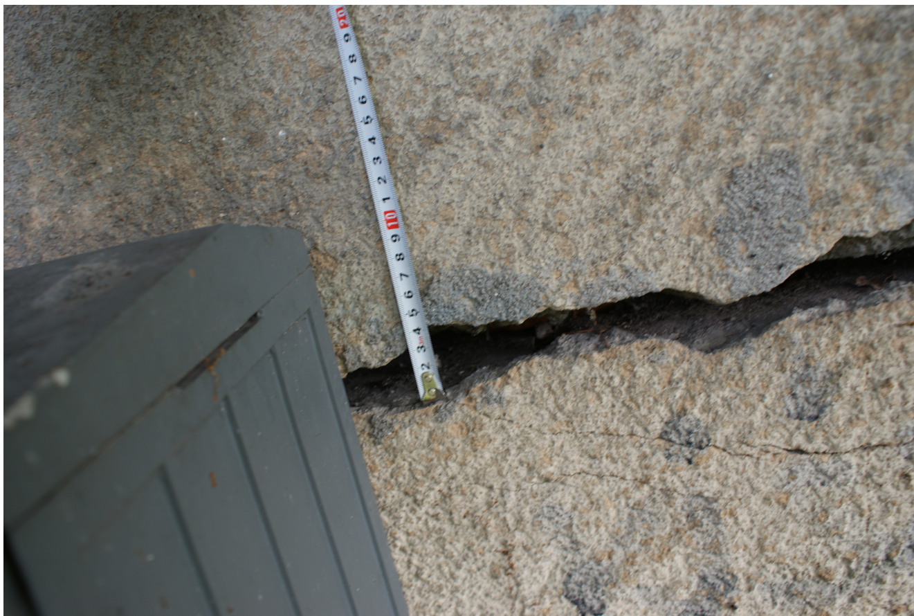
Ilustracja 2: Spękania muru od strony południowej
