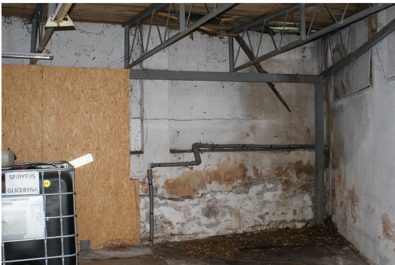
Ilustracja 5: Widok od wnętrza garażu - widoczny zawilgocenia i uszkodzenia muru
