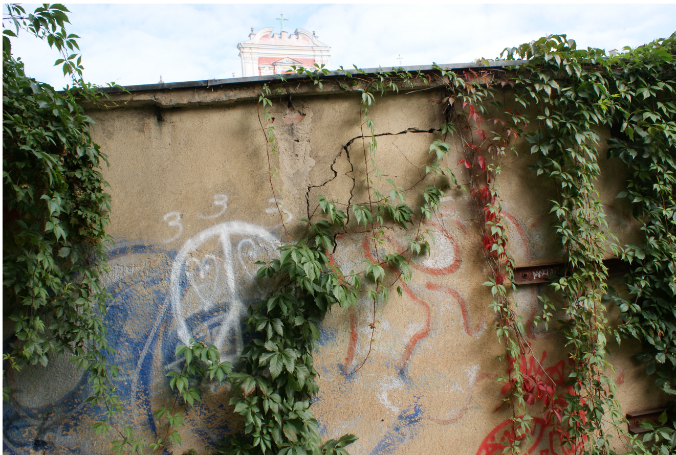
Ilustracja 4: Widok od strony południowej - spękania oraz istniejące wzmocnienia muru
