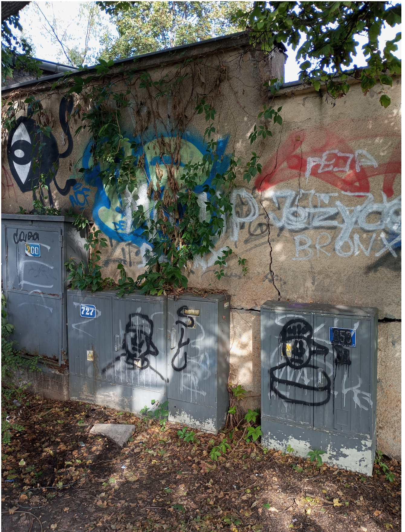
Ilustracja 1: Widok muru od strony południowej - widoczne szafy elektryczne oraz spękania poziome
