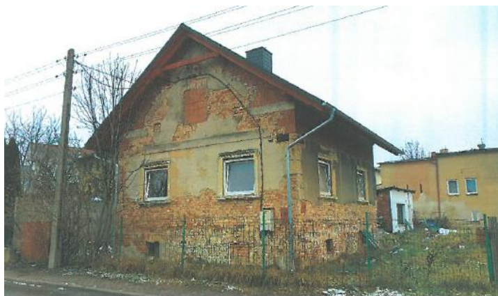
Budynek mieszkalny - elewacja zachodnia i południowa (miejsce „dobudówki”)
