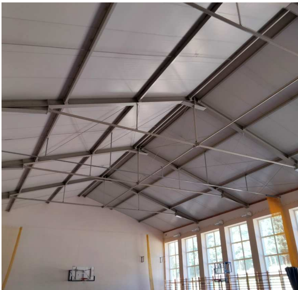
Rysunek 2 Układ konstrukcyjny hali gimnastycznej
