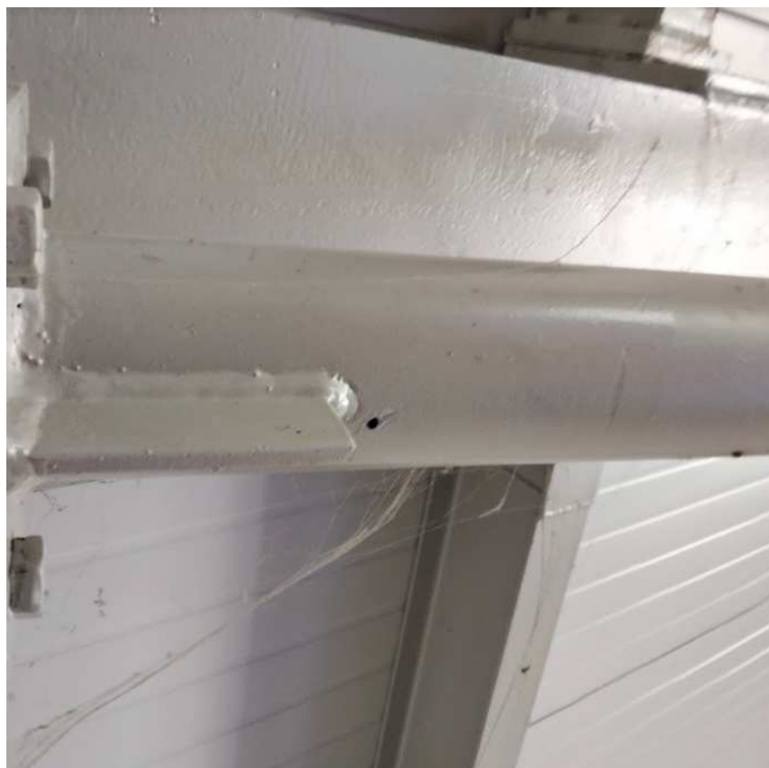
Rysunek 8 Przewiercenie ściąggu w celu oceny jego grubości
