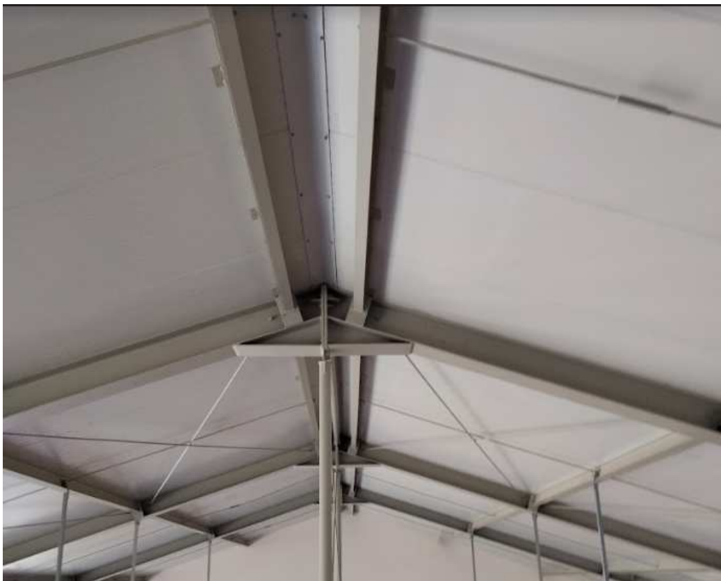
Rysunek 4 Brak stężenia zwieńczającego płatwi w kalenicy
