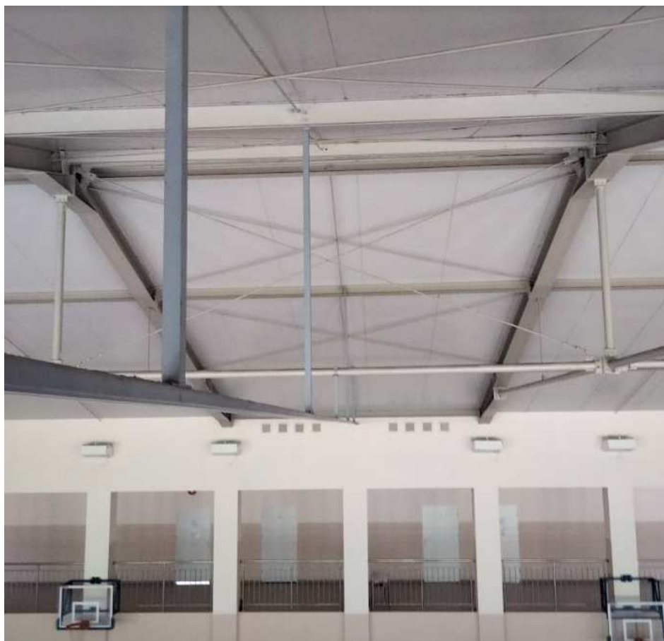
Rysunek 9 Układ stężeń połączeniowych pionowych oraz poziomych
