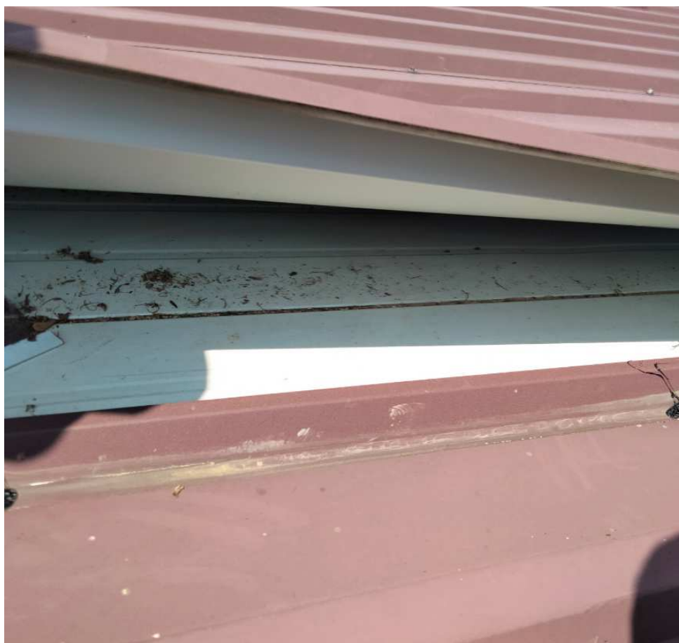
Rysunek 3 Pod warstwą blachy trapezowej widoczna płyta warstwowa ścienna.
