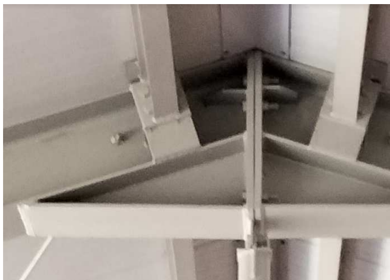
Rysunek 6 Połączenie kalenicowe dźwigarów
