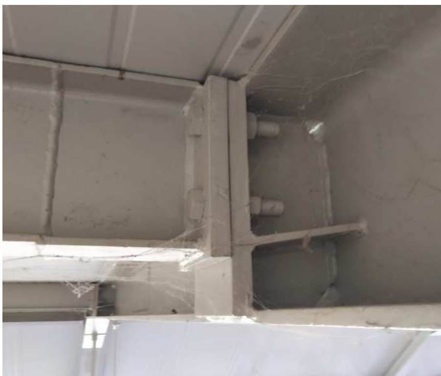
Rysunek 5 Schemat węzła połączenia płatwi z dźwigarem
