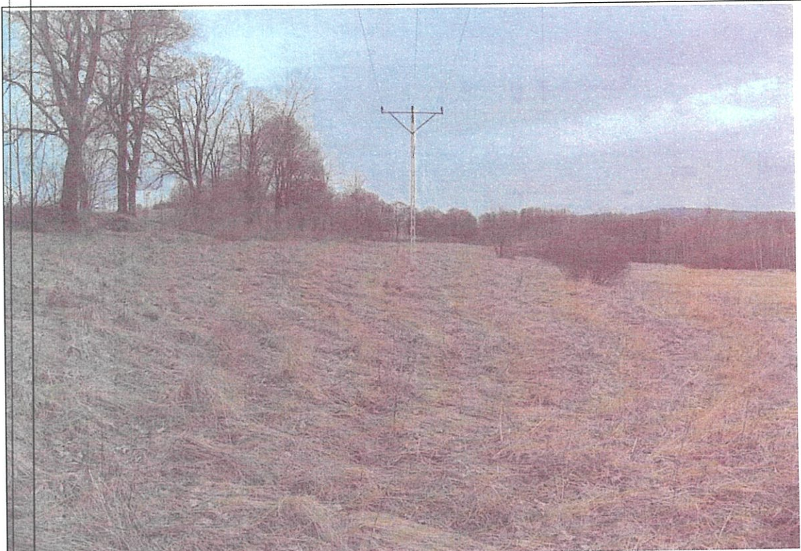
Słup energetyczny w najbardziej aktywnej części osuwiska.
