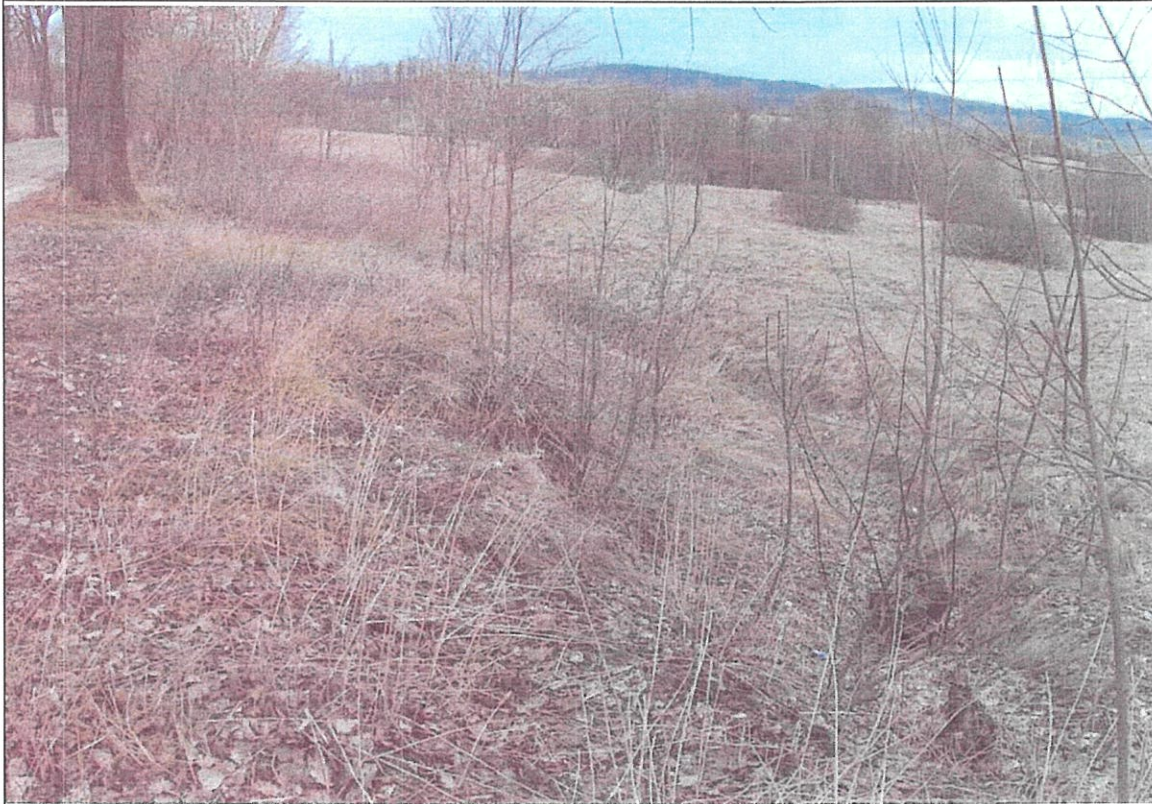
Skarpa wtórna i rów rozpadlinowy poniżej drogi.
