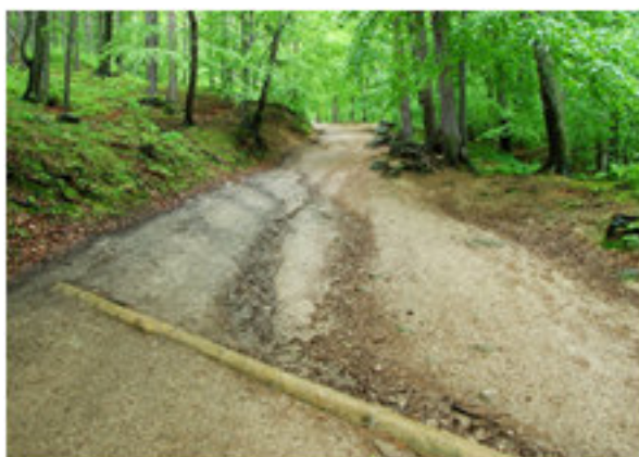
Wodospust z pojedynczego okrągłaka
