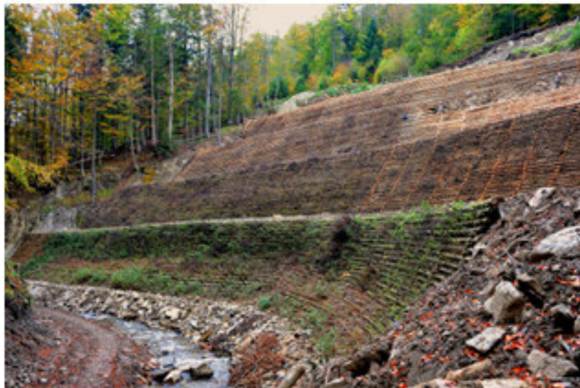
Kaszycy z pędami wierzby zabezpieczająca osuwisko pod drogą podcinaną przez ciek – pędy rozpoczęły wegetację jeszcze przed zakończeniem budowy. Nadleśnictwo Stuposiany. Źródło: Archiwum CKPŚ.
