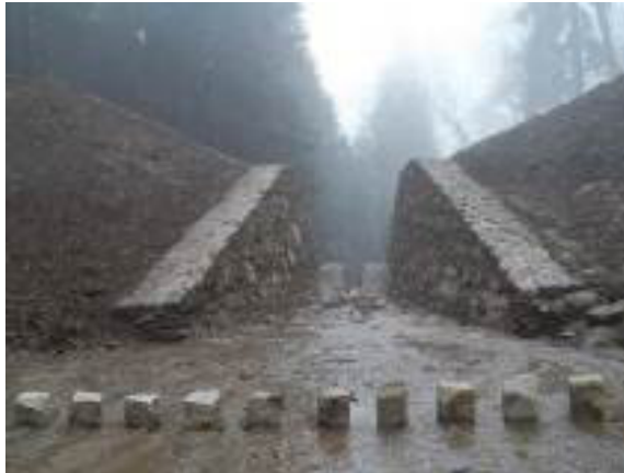
Suchy zbiornik w I-ctwie Jawornica z przelewem szczelinowym (przeplawką) (fot. N-ctwo Międzylesie)
