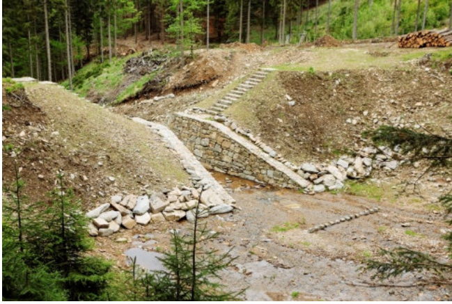
Widok na zaporę czołową dawnego zbiornika na cieku do spławu drewna przerobionego na zbiornik przeciwpowodziowy – Nadleśnictwo Międzylesie. Źródło: Archiwum CKPŚ. (rys. na górze)
