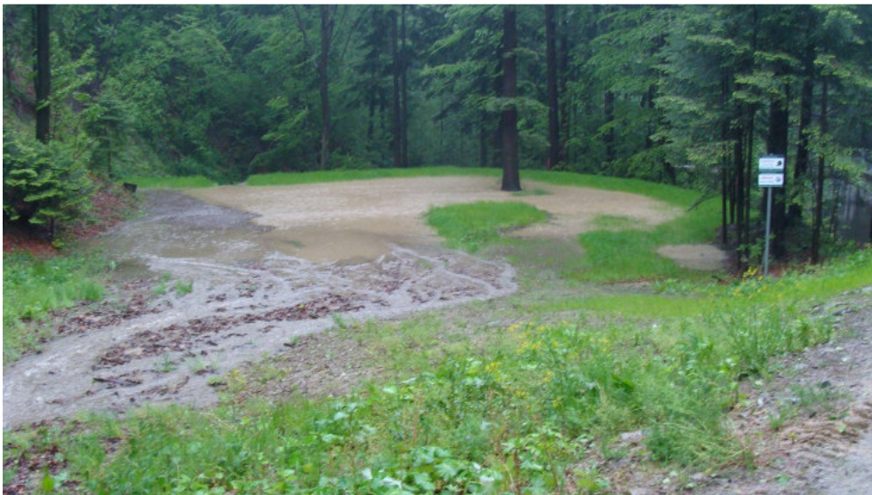
Zbiornik retencyjny na pływ powierzchniowy zaraz po wybudowaniu, dodatkowo zasilany wodą spływającą z leśnej drogi – Nadleśnictwo Piwniczna. Źródło: zasoby własne Nadleśnictwa Piwniczna
