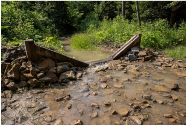
Próg powyżej brodu ukierunkowujący wodę na bród.
