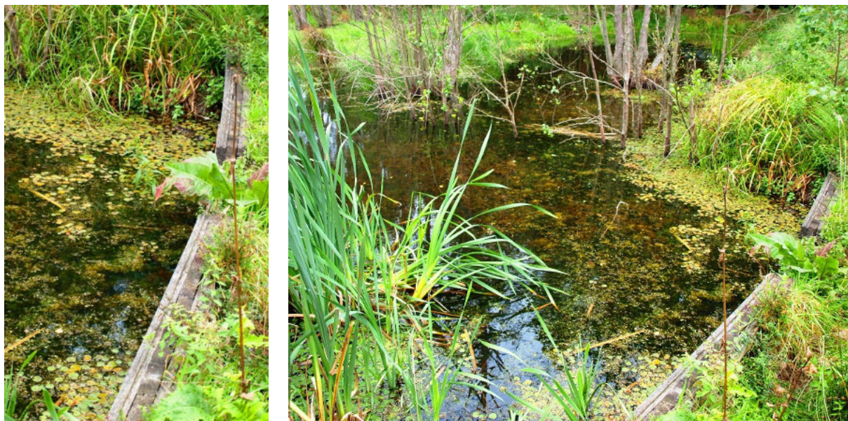
Nawet małe zastawki ulegają naporowi wody jeśli pozbawione są wzmocnień zastrzałem, oczepem i podparciem od dołu umocnieniem. Fot. Z. Filipek Źródło: Archiwum CKPS
