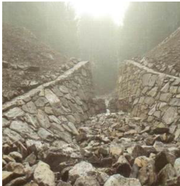
Przeławka szczelinowa na suchym zbiorniku w I-ctwie Jawornica (fot. N-ctwo Międzylesie)
