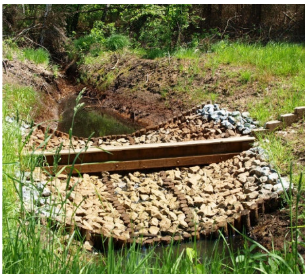
Dobrze ubezpieczony próg z pojedynczej ścianki szczelnej. Fot. Z. Filipek. Źródło: Archiwum CKPŚ.
