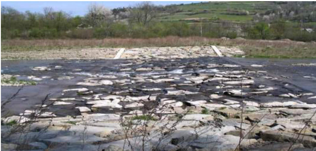
Bystrze regularne na potoku Porębianka
