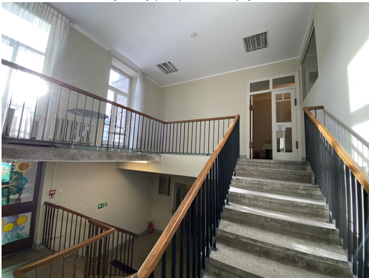
Fot nr 20 - Widok na boczna klatkę schodową - poziom parteru – inwentaryzacja
