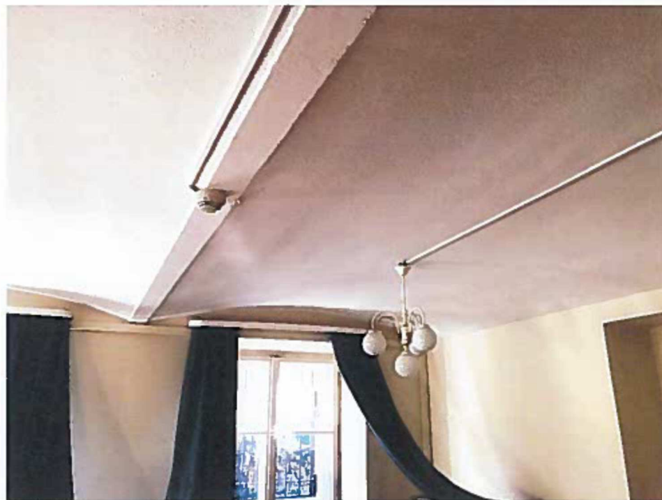
Widok stropów odcinkowych nad kondygnacją podziemną
