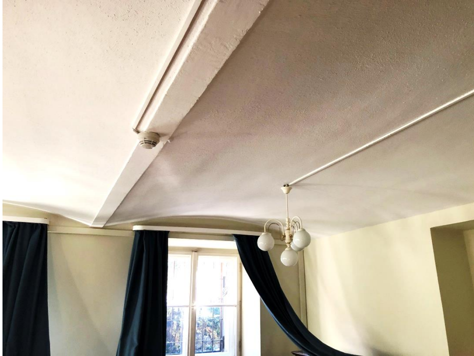
Widok stropów odcinkowych nad kondygnacją podziemną
