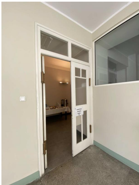
Fot nr 25 - Widok na drzwi wewnętrzne bocznej klatki schodowej
