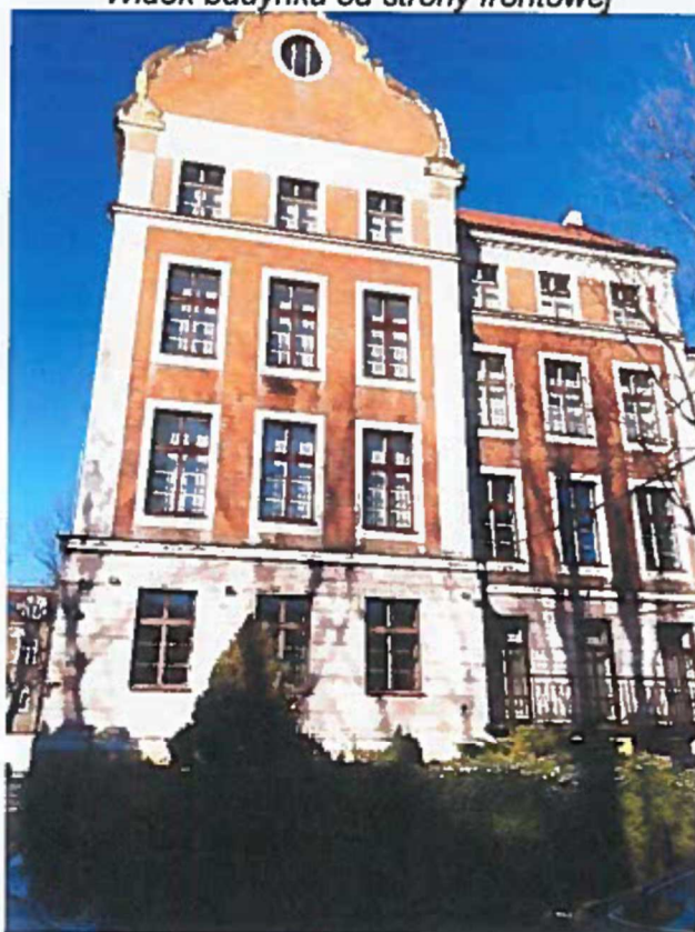
Widok budynku od strony bocznej (południowej)
