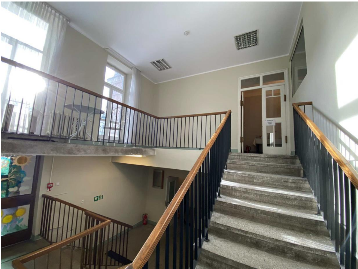
Fot nr 20 - Widok na boczną klatkę schodową - poziom parteru
