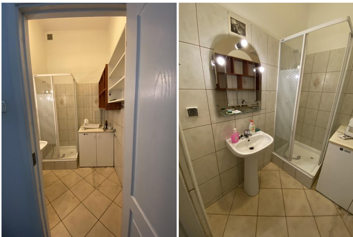
Fot nr 5,6 - Widok pomieszczenia łazienki parteru pom. nr 1.8 - inwentaryzacja
