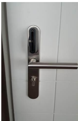
istniejące drzwi do pomieszczeń
