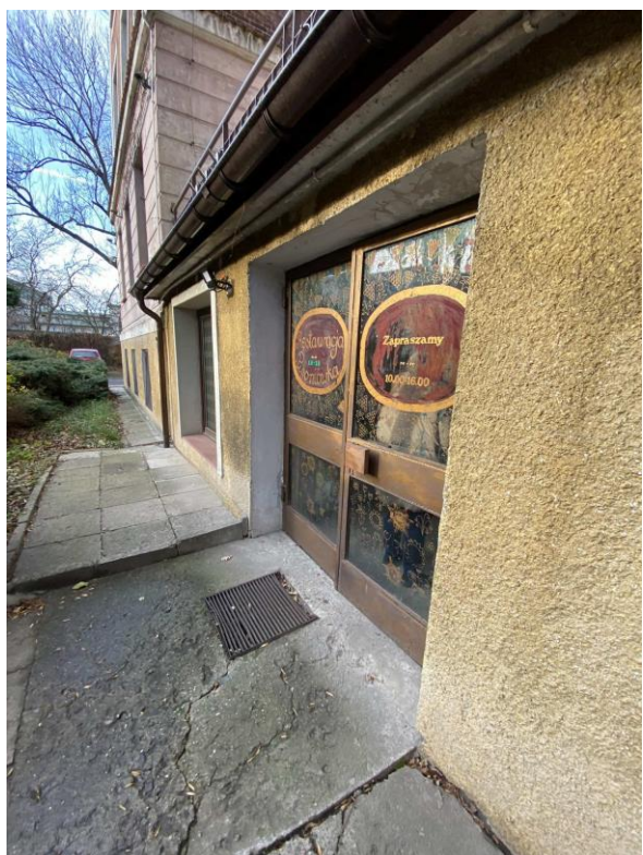
Fot nr 26 Widok na drzwi zewnętrzne bocznej klatki schodowej
