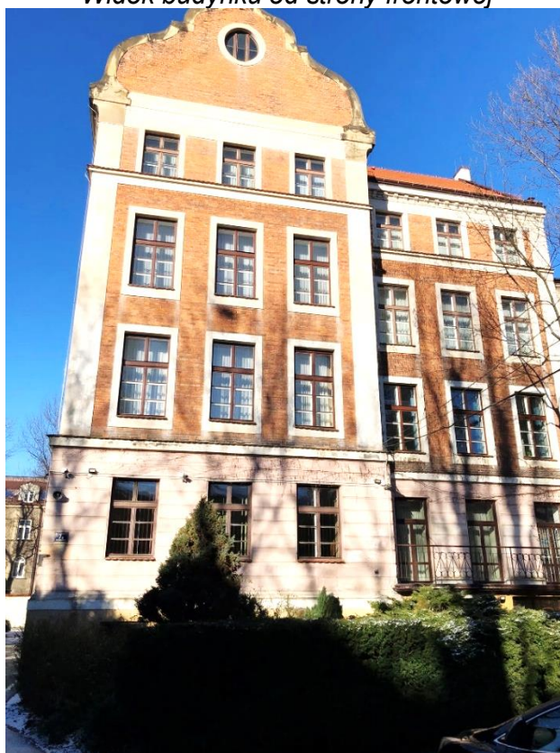
Widok budynku od strony bocznej (południowej)
