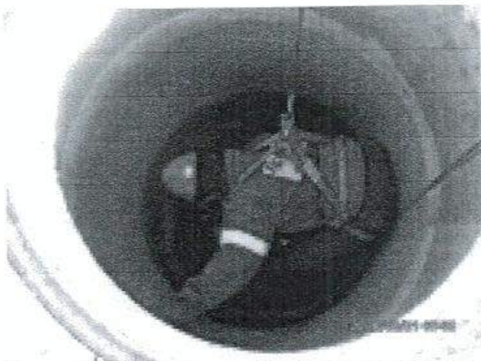
Rysunek 3 Wejście serwisanta do separatora w celu wyciągnięcia z prowadnic sekcji lamelowych
