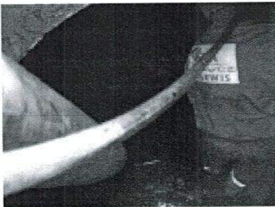
Rysunek 8 Usunięcie szlamu z osadnika i jego mycie ciśnieniowe
