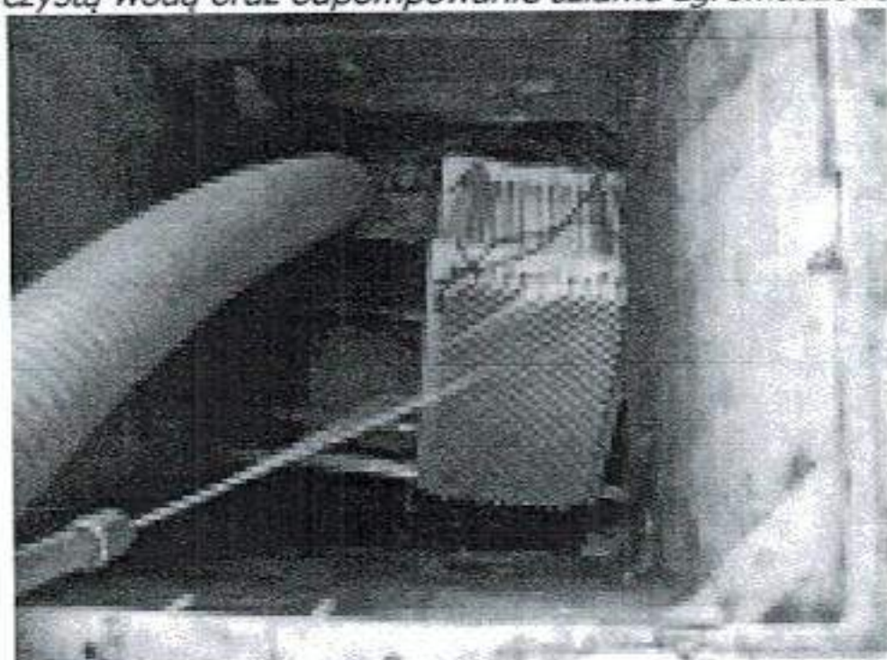
Rysunek 4 Mycie ciśnieniowe sekcji lamelowych
