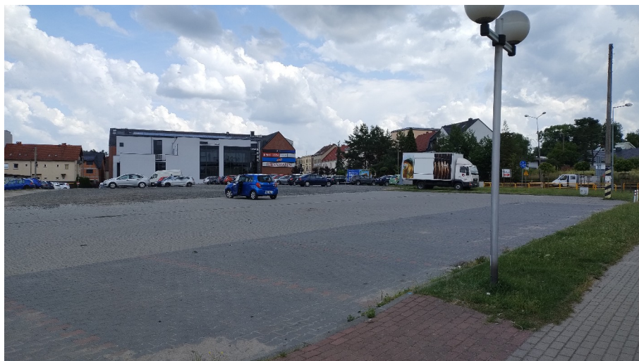
Ilustracja 2: Istniejące utwardzenie kostką brukową
