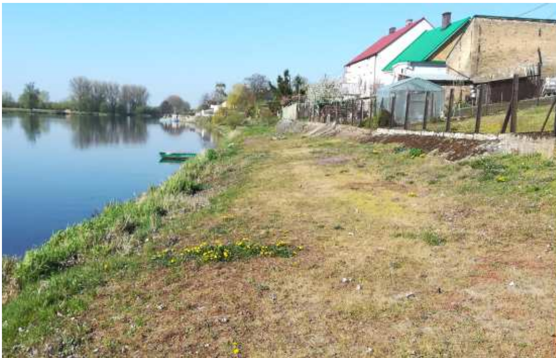
Zdjęcie 2 Stan istniejący
