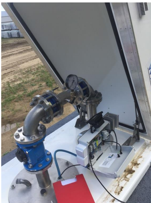
Pomiar studni głębinowych.
