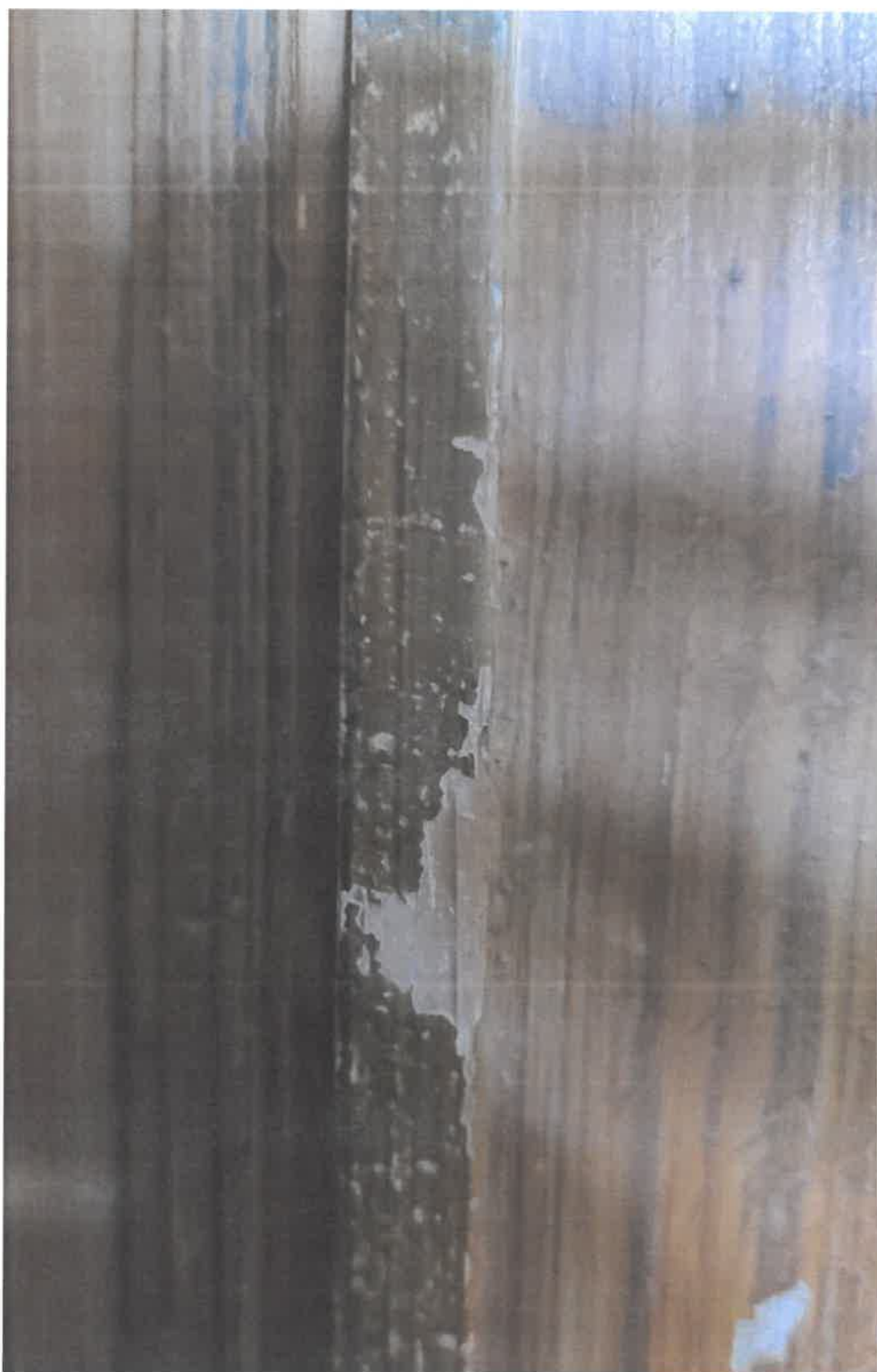
Zdj.10. Prospekt organowy XVIII w., kościół p.w. Świętej Trójcy, parafia Sokolowiec, gm. Świerzawa, woj. dolnośląskie. Na fotografii widoczny fragment z osypującą się dekoracją mazeru. Pod późniejszym przemalowaniem widoczna biała warstwa.
