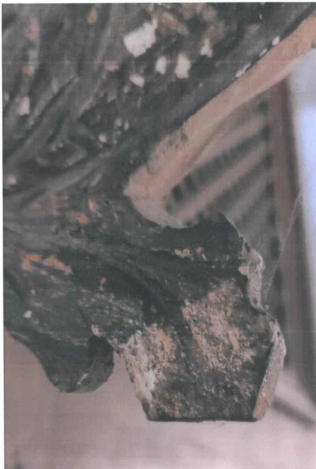
Zdj.16. Prospekt organowy XVIII w., kościół p.w. Świętej Trójcy, parafia Sokółwiec, gm. Świerzawa, woj. dolnośląskie. Fragment dekoracji snycerskiej. Widoczna ciemna, spękana warstwa przemalowania, która ma tendencje do łuszczenia i odspajania.
