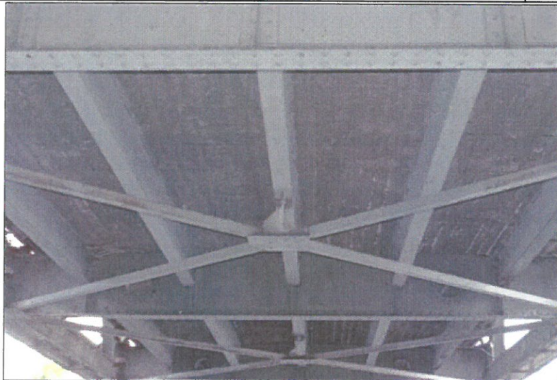
Fot. 3 Widok płyty pomostowej od spodu
