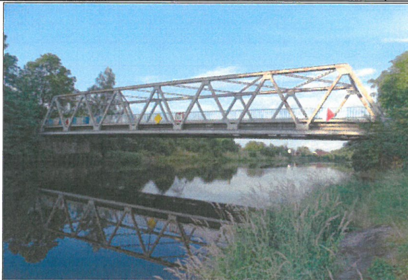
Fot. 1 Widok mostu z boku
