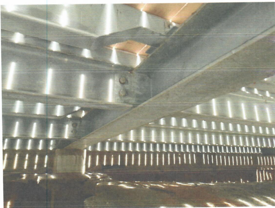
Fot.20 Widok rozbieralnej konstrukcji molo
