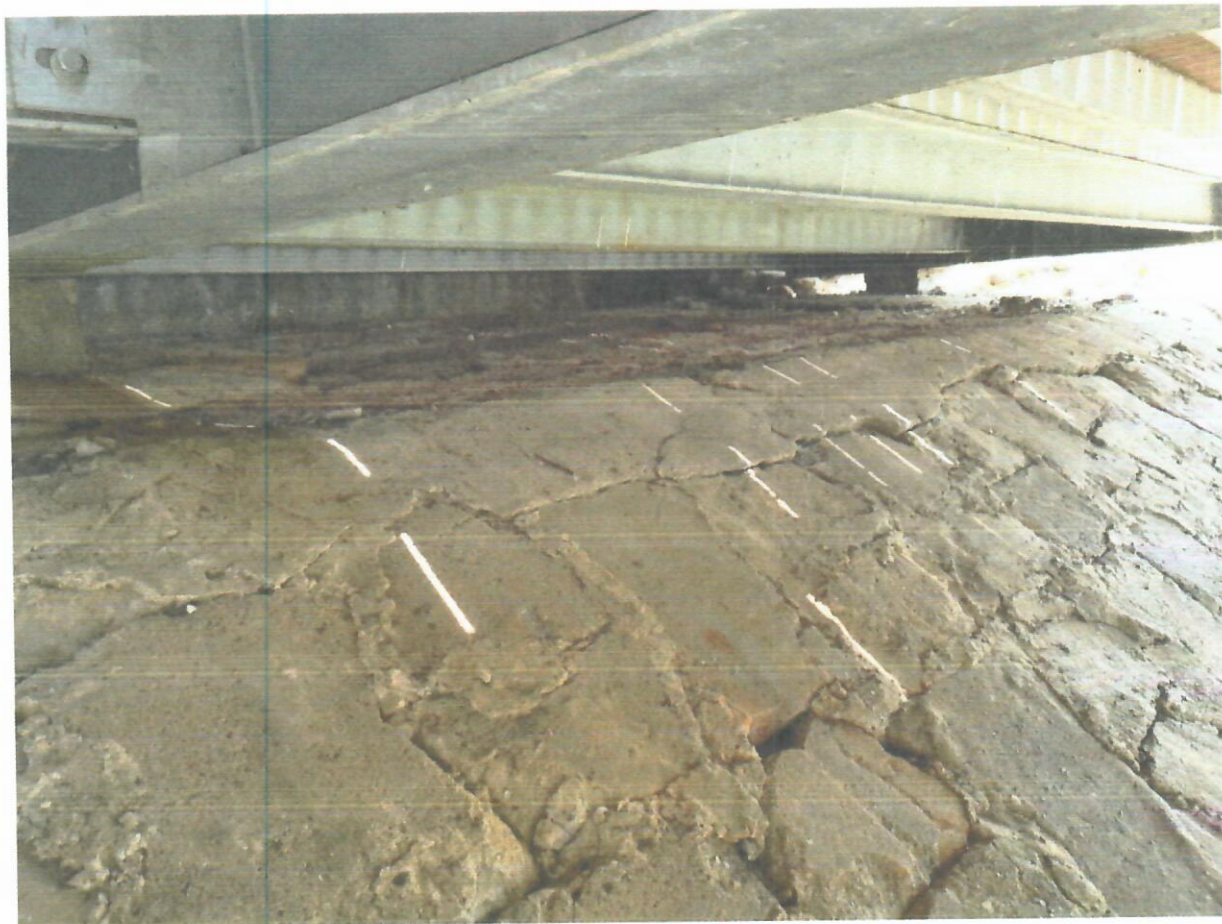
Fot. 6 Wschodnia zapadnięta część umocnienia u nasady moła
