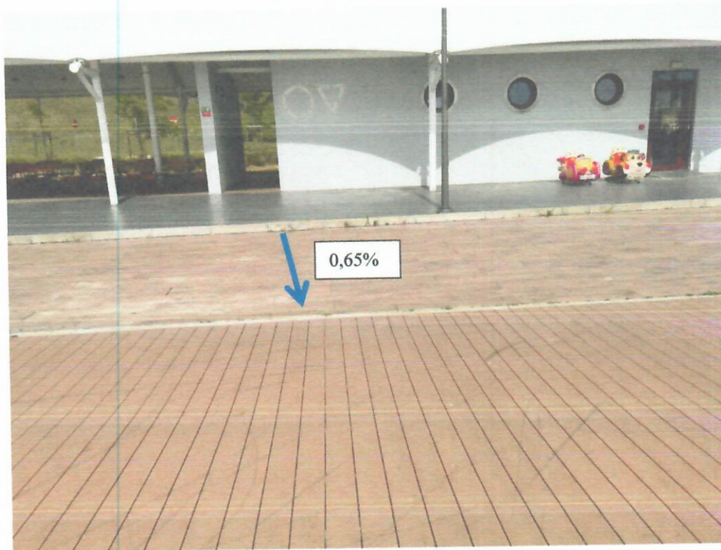
Fot.3 Spadek powierzchni utwardzonego placu przy nasadzie moło
