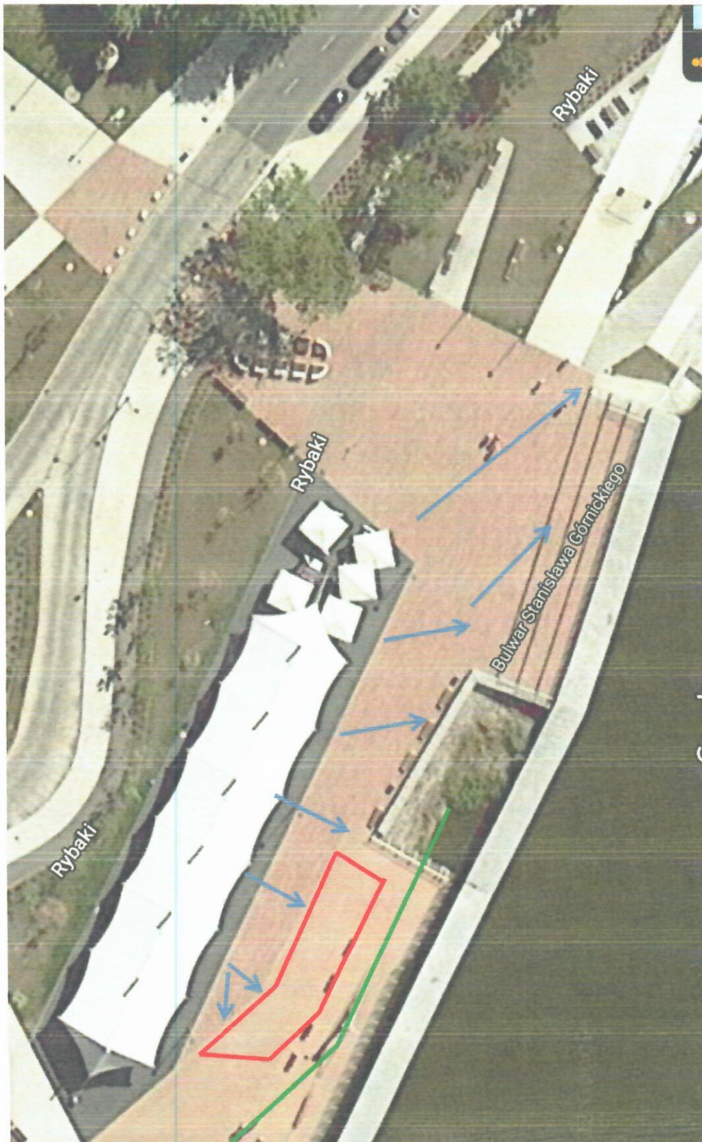
Fot.21 Fragment utwardzonego placu z którego wody opadowe spływają na uszkodzone umocnienie nabrzeża oznaczony kolorem czerwonym. Niebieskie strzałki to kierunki spływu wód opadowych w powierzchni utwardzonej w pobliżu nabrzeża i z zadaszenia namiotowego
