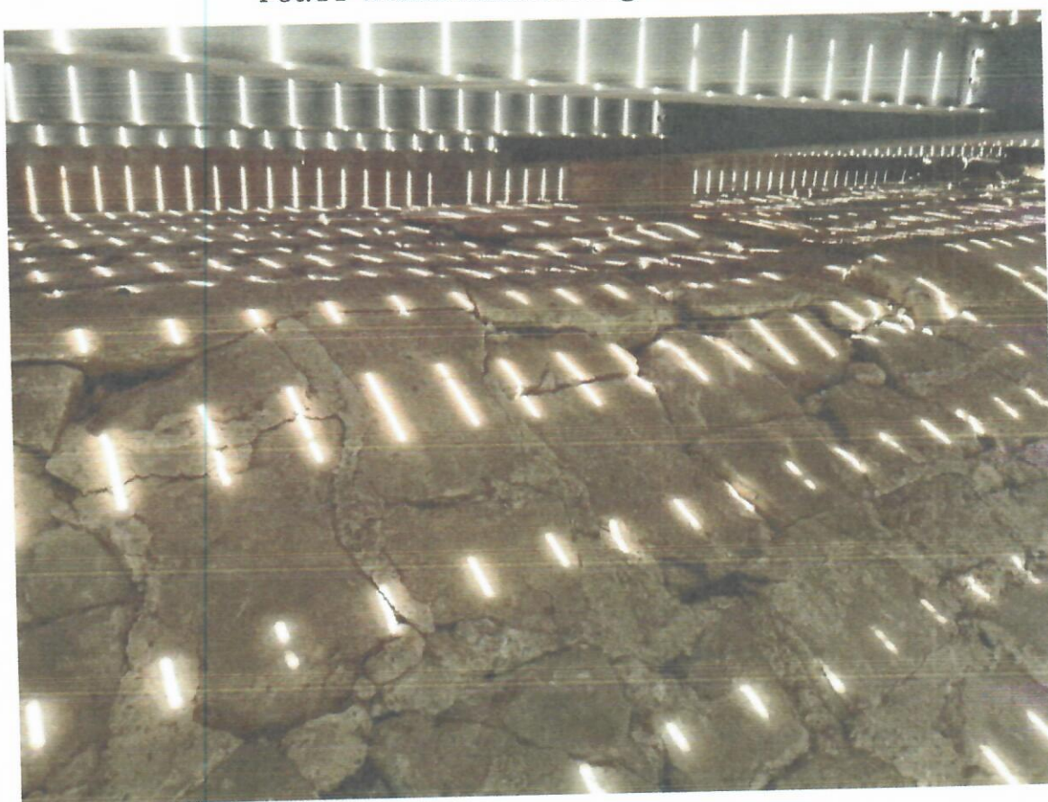
Fot.12 Widok uszkodzonego nabrzeża
