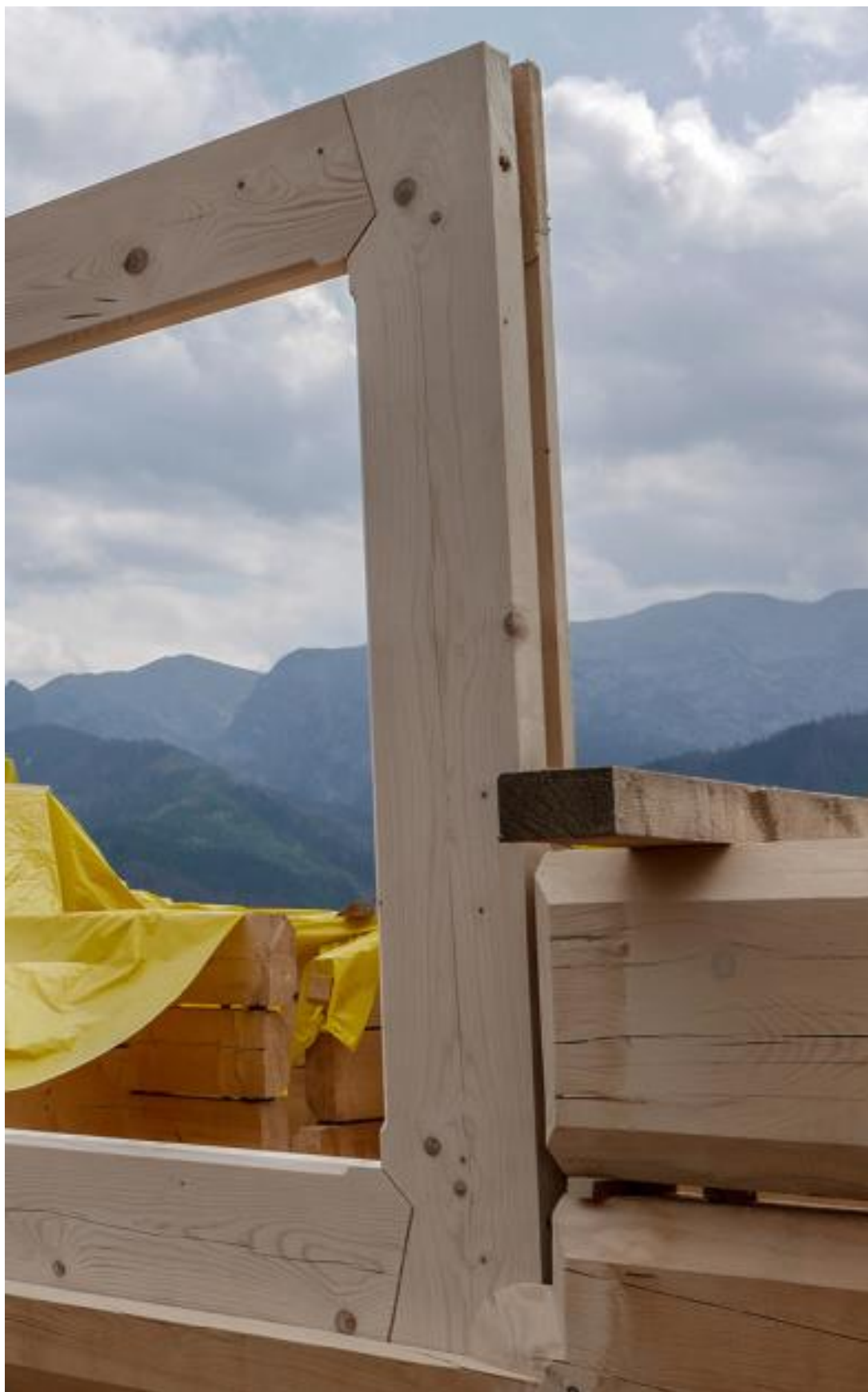
Fotografia nr 1 Słup wiązany w trakcie budowy
