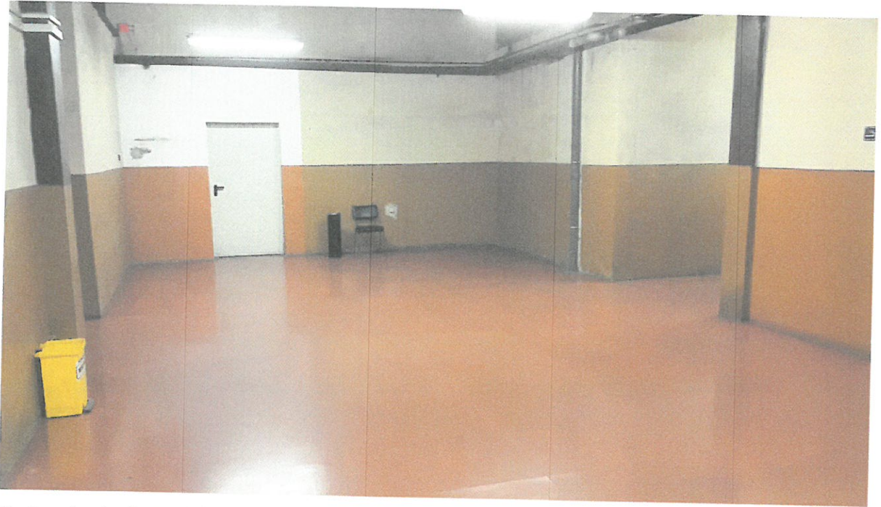
Parter budynku wielofunkcyjnego (BW), w kierunku klatki zachodniej – wydzielona pożarowo.
