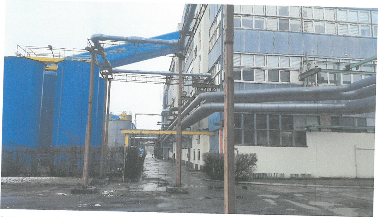
Budynek od strony południowej z przejazdem od strony zachodniej.
