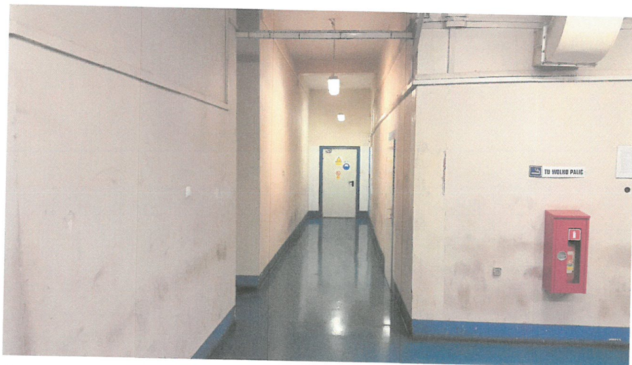
Czwarte piętro BW. Łącznik w kierunku CŁII – zamknięty drzwiami EI 60,
