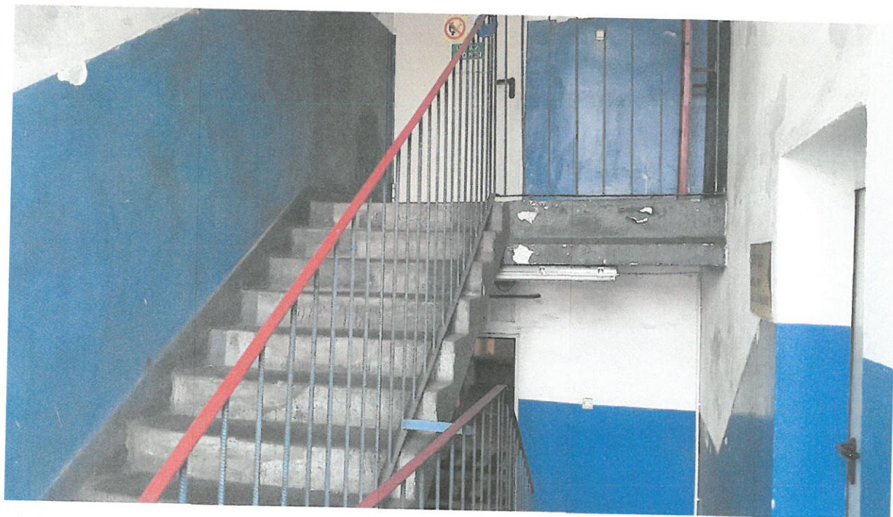
Klatka w kotłowni.
