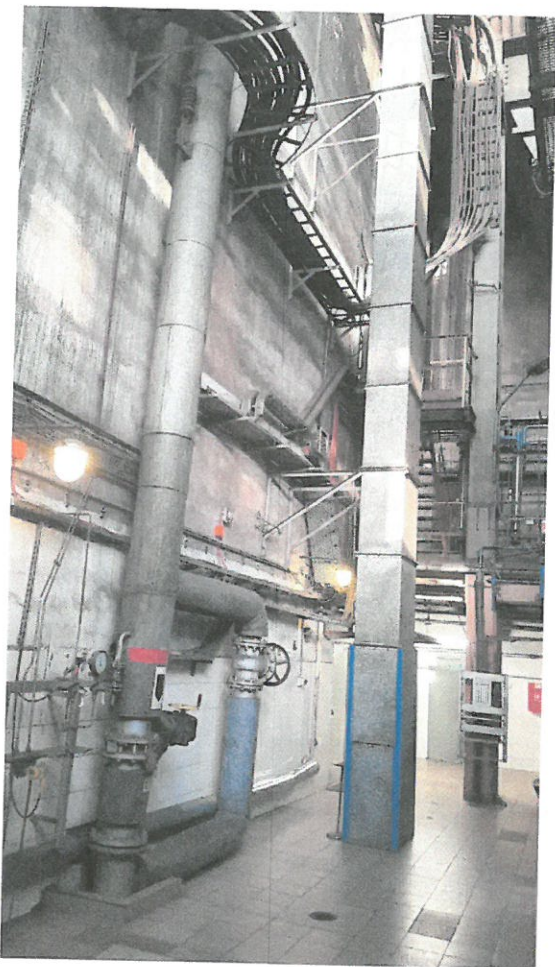
Ściana między CŁII a BW
