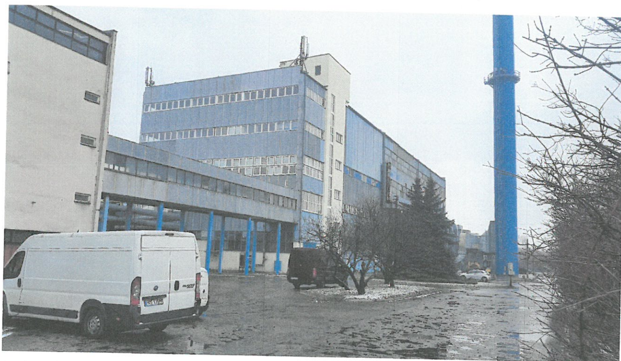
Budynek od strony wschodniej. Na pierwszym planie łącznik do obiektu Cł I
