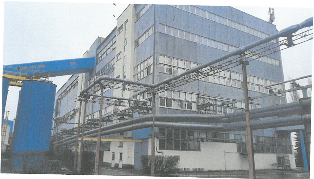
Budynek od strony południowo – zachodniej.
