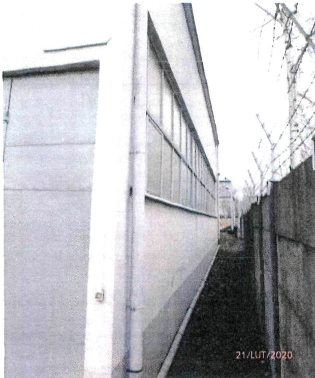
Fot. 3. Elewacja południowo-wschodnia
