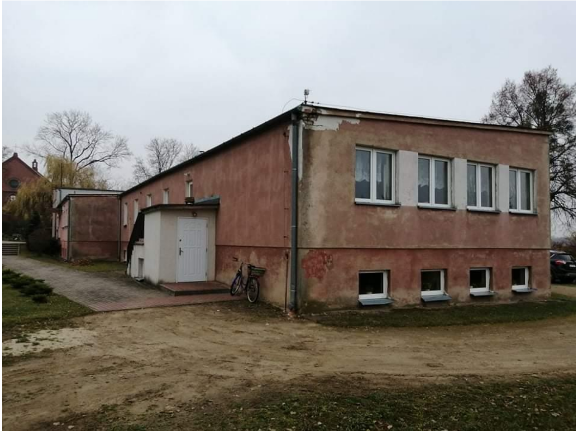
Zdj. Elewacja północna
