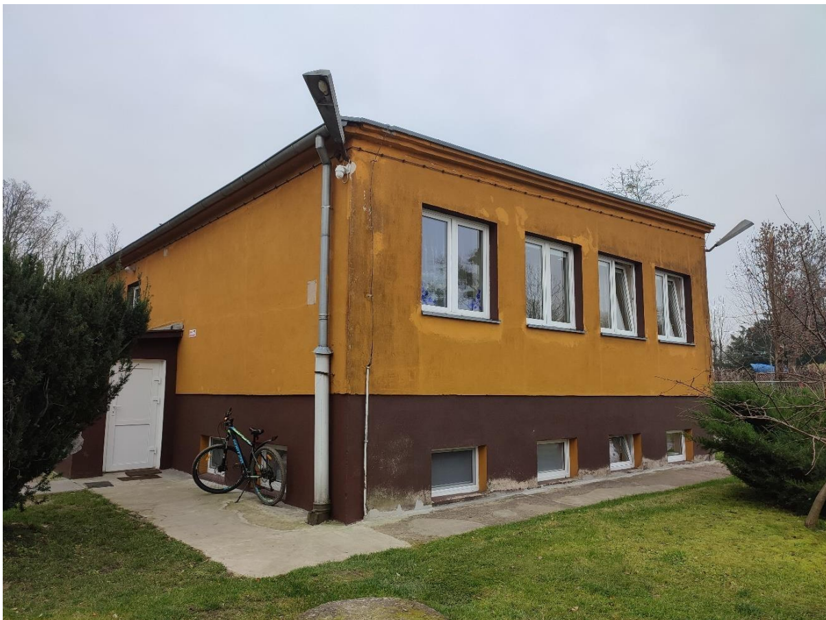
Zdj. Elewacja północno-zachodnia
