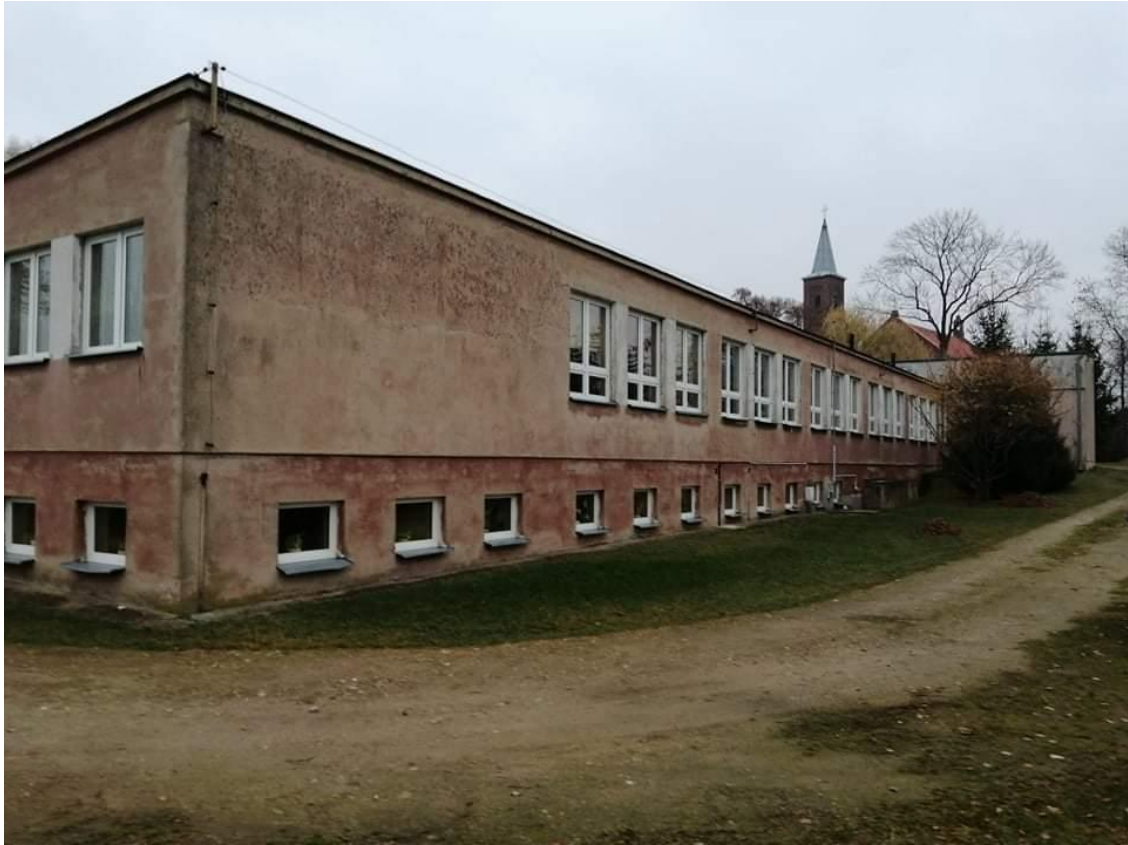
Zdj. Elewacja zachodnia
