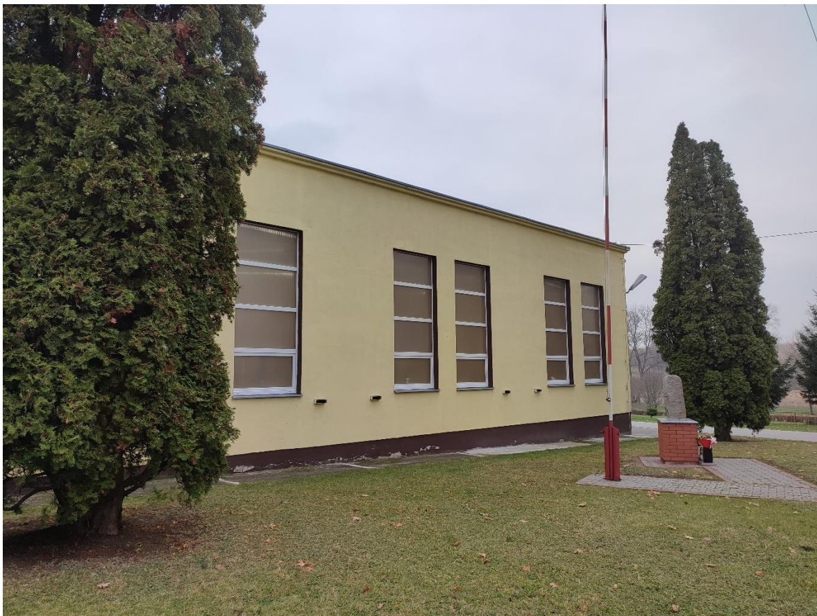
Zdj. Elewacja południowo-wschodnia
