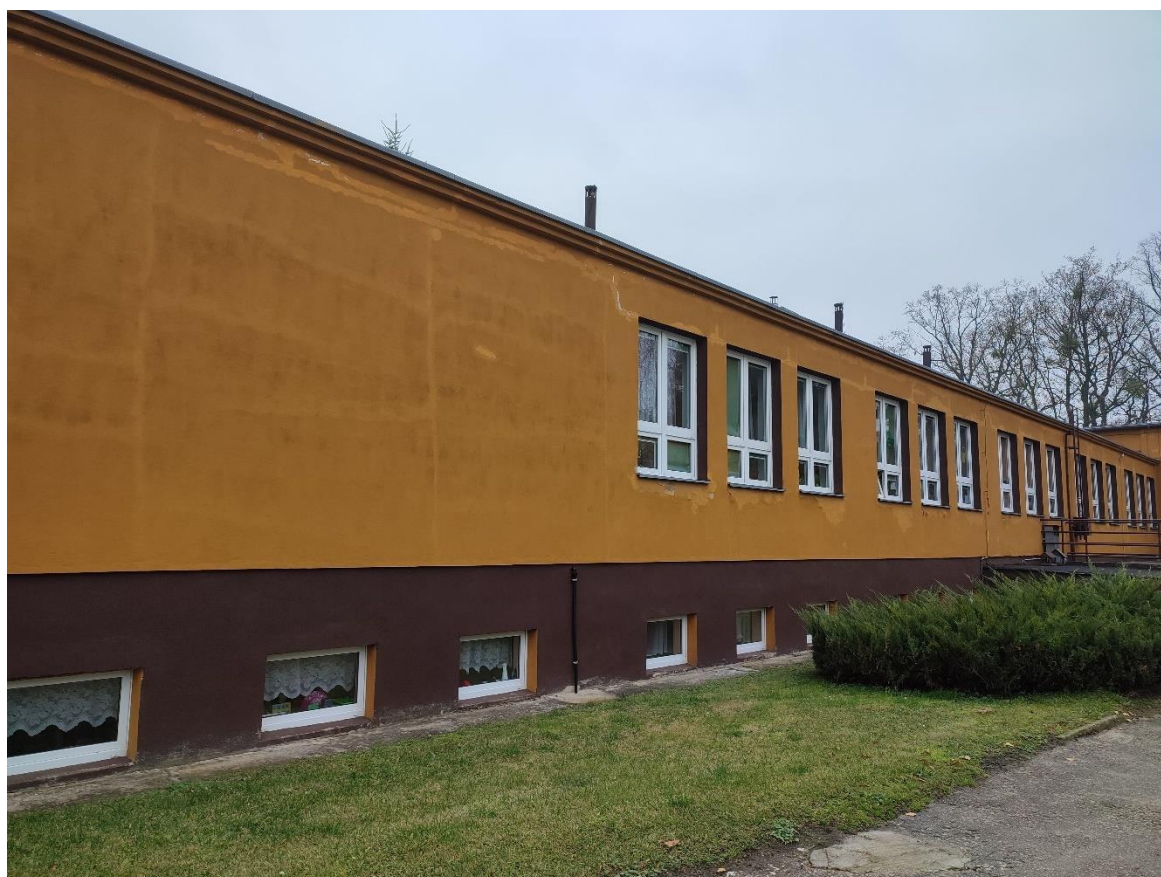
Zdj. Elewacja północno-zachodnia
