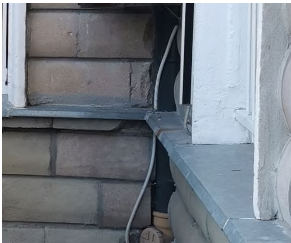
Detal gzymsu Wnęka z rurą deszczową
