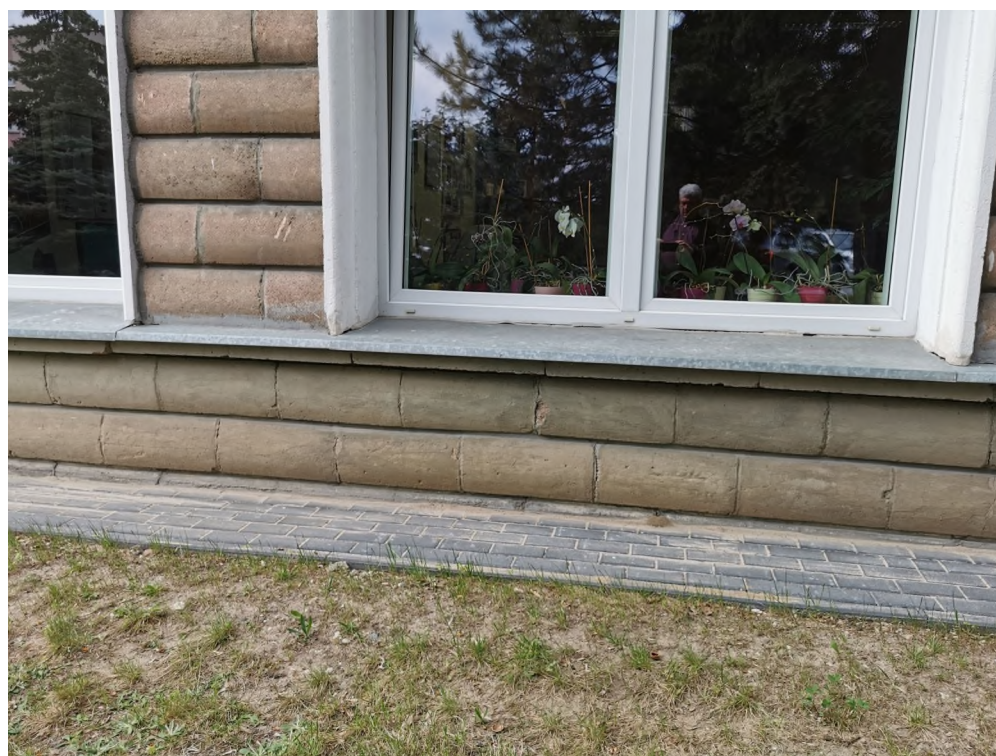
Gzyms dolny Obramowania okien
