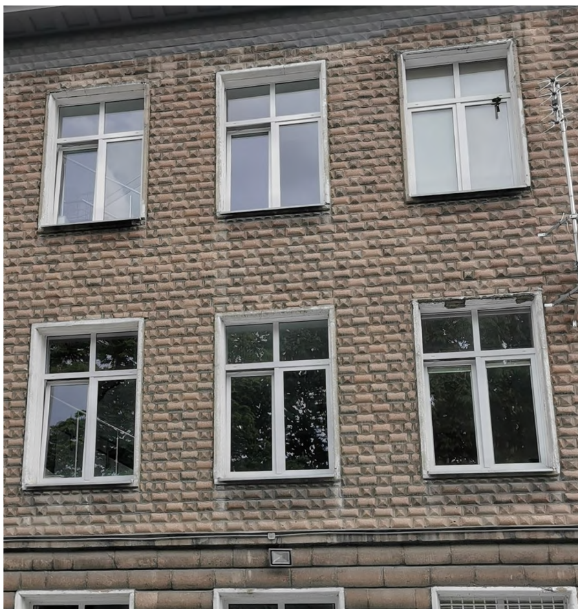
Obramowania okien do naprawy
