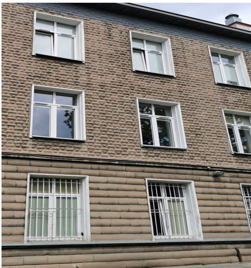
Kraty okienne do demontażu i okna do wymiany
