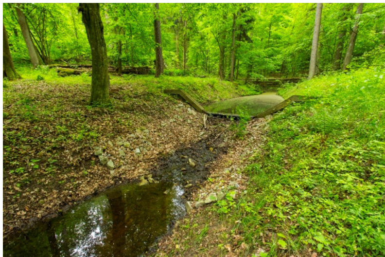
Piętrzenie stałe – ścianka szczelna podparta bystrzem. Źródło: Archiwum CKPŚ.
