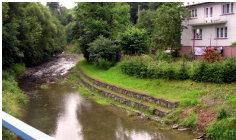
Fot. 3. Zabezpieczenie konstrukcji budowlanych
