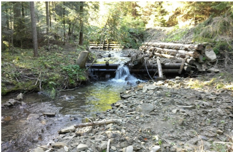
Podmyty próg w rok po wybudowaniu. Brak zamknięcia niecki wypadowej stabilizującego dno. Źródło. Archiwum fotograficzne CKPŚ.
