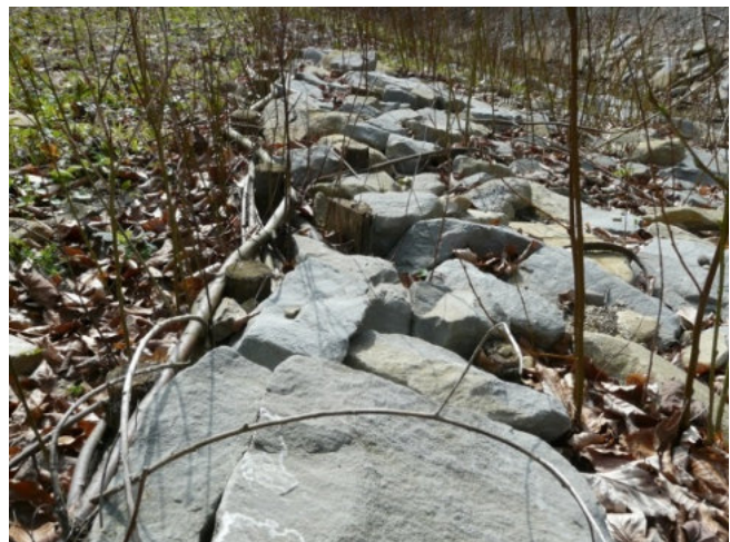
Zabezpieczony faszyną narzut kamienny z nasadzeniami wierzbowymi. Źródło: Archiwum CKPŚ
