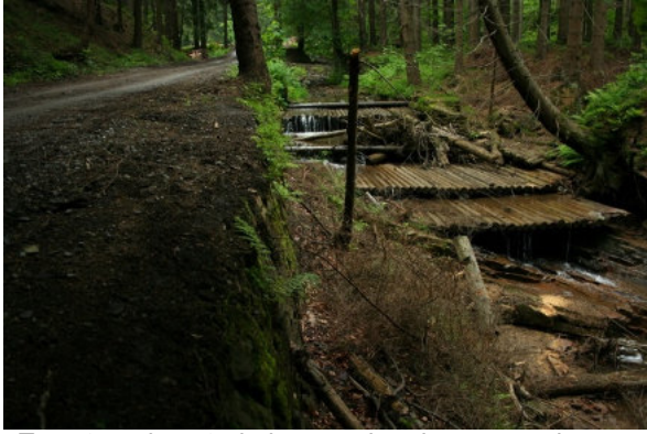
Tego typu konstrukcje są mało odporne na niszczące działanie wód wezbraniowych. Źródło: Archiwum CKPS
