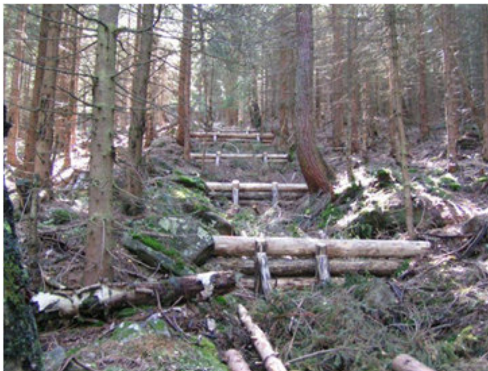
Przegrody drewniane wypełnione gałęziówką na szlakach zrywkowych
