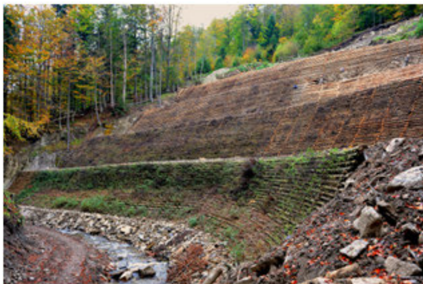
Kaszycy z pędami wierzby zabezpieczająca osuwisko pod drogą podcinaną przez ciek – pędy rozpoczęły wegetację jeszcze przed zakończeniem budowy. Nadleśnictwo Stuposiany. Źródło: Archiwum CKPŚ.
