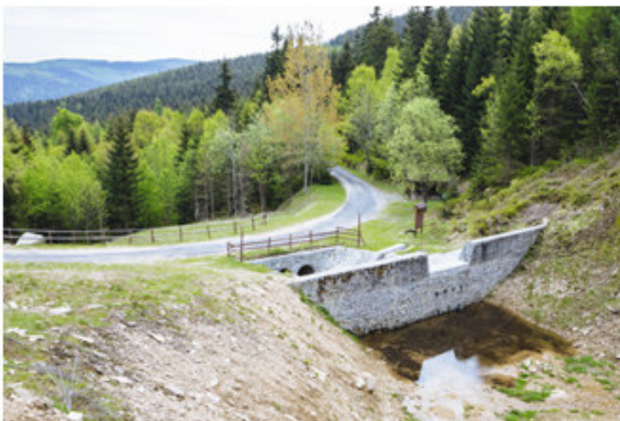
Opróżniona z zalegającego rumoszu wysoko położona na zboczu góry zapora w Nadleśnictwie Świeradów. Źródło: Archiwum CKPŚ.
