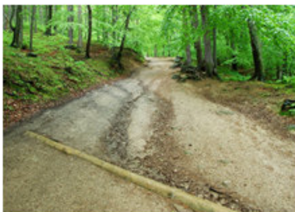
Wodospust z pojedynczego okrągłaka
