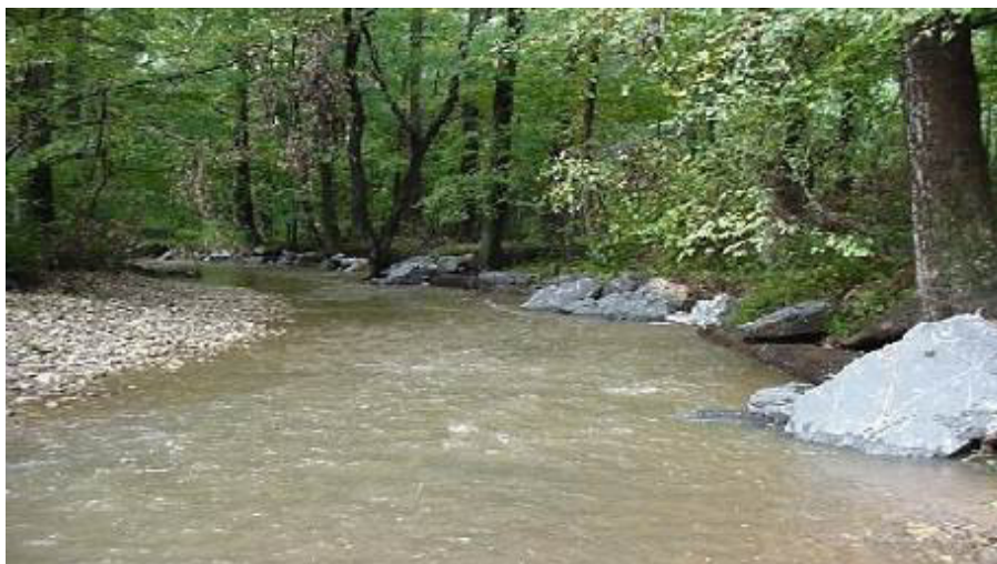
Zabezpieczenie brzegu wklęsłego głazami (fot. Montgomery County Department of Environmental Protection)
