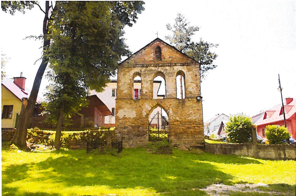
Widok na dzwonnice, z lewej mur pierwotny, z prawej betonowa podmurówka
