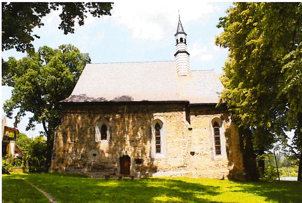
Widok na elewację południową (od strony ul. Grunwaldzkiej)
