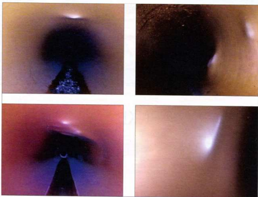
Fot. 3 | Przykłady wgniatania się do wnętrza rur kamieni lub innych twardych przedmiotów
