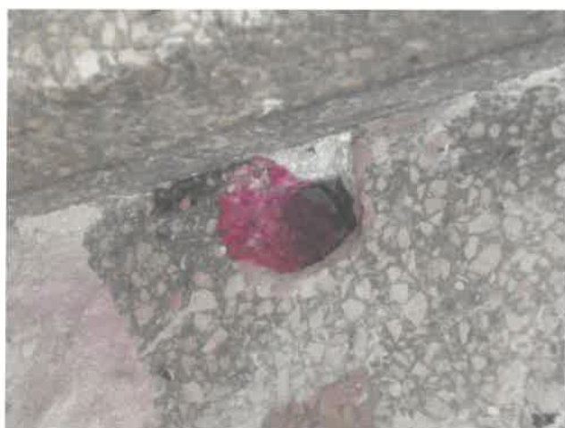
Rys. 5.2. Badanie stopnia karbonatyzacji betonu
