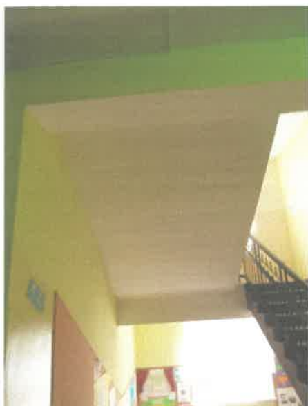
Fot. 8.11. Spód płyty biegowej, brak widocznych pęknięć i rys, geometria ustroju nośnego prawidłowa. Fot. 8.12. Podciąg żelbetowy w stanie dobrym.
