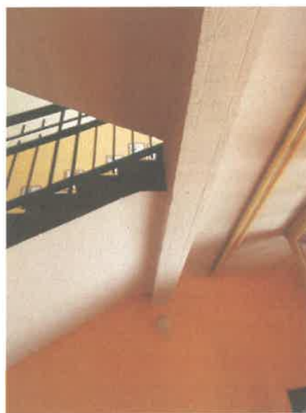
Fot. 8.11. Spód płyty biegowej, brak widocznych pęknięć i rys, geometria ustroju nośnego prawidłowa. Fot. 8.12. Podciąg żelbetowy w stanie dobrym.
