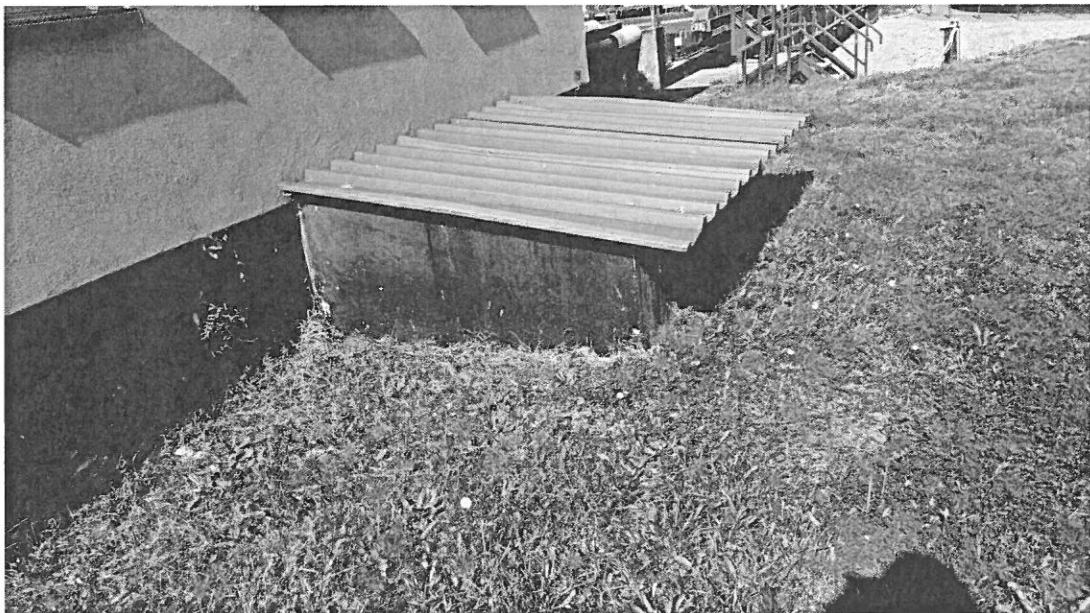
Fot. nr5 – Budynek krat Ob. nr 3 – elewacja wsch.
