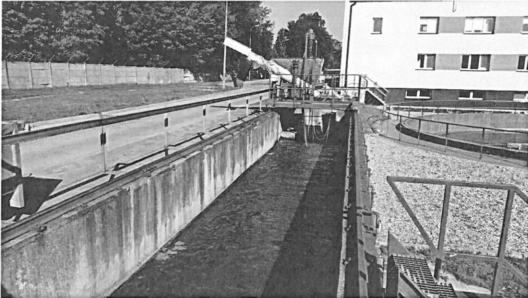
Fot. nr7 – Piaskownik napowietrzany Ob. nr 4
