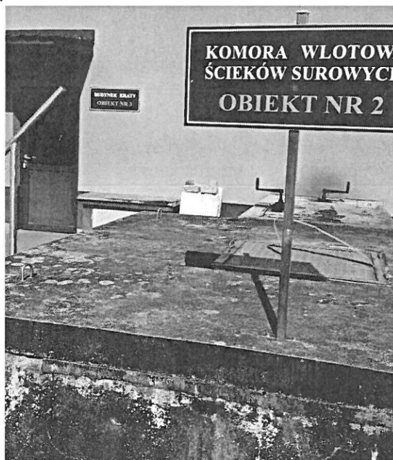
Fot. nr3 – Komora wlotowa Ob. nr 2
