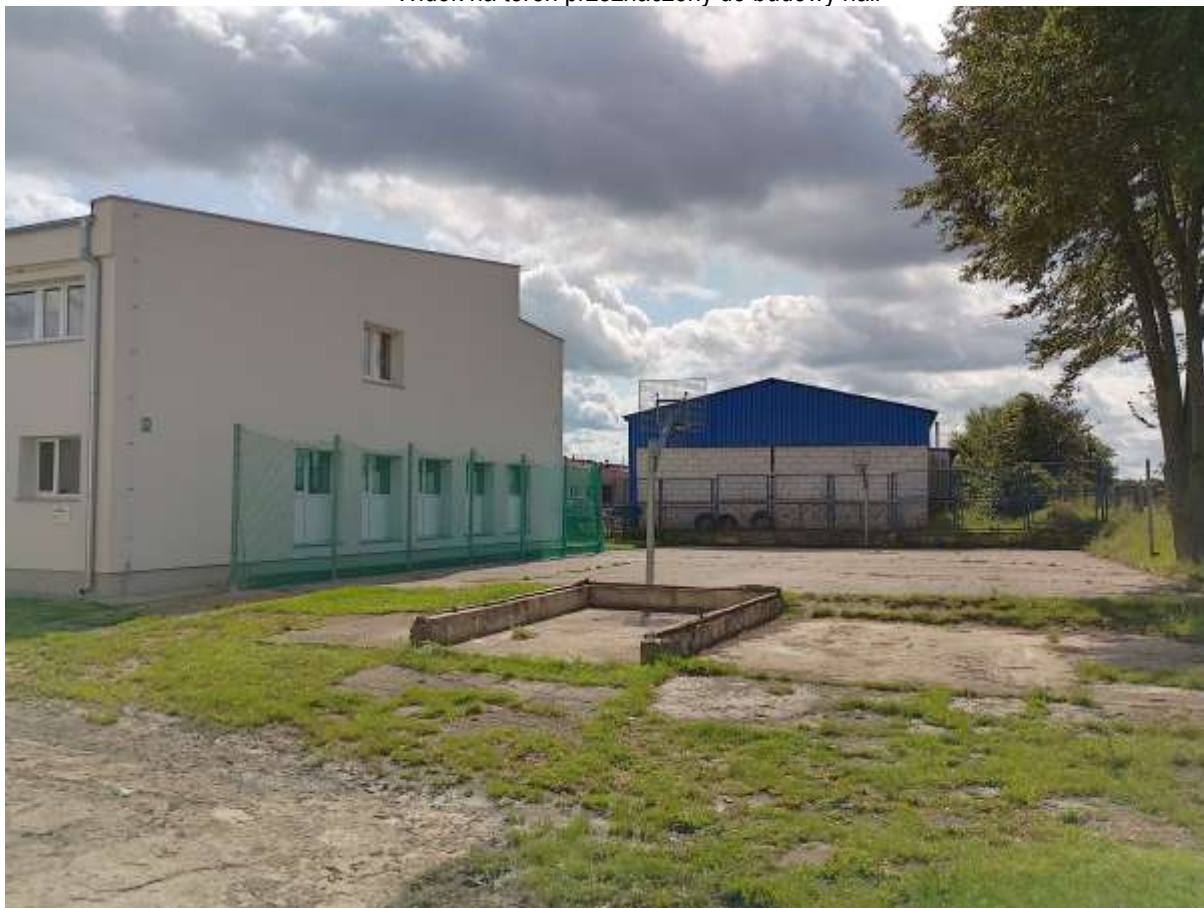
Widok na teren przeznaczony do budowy hali
