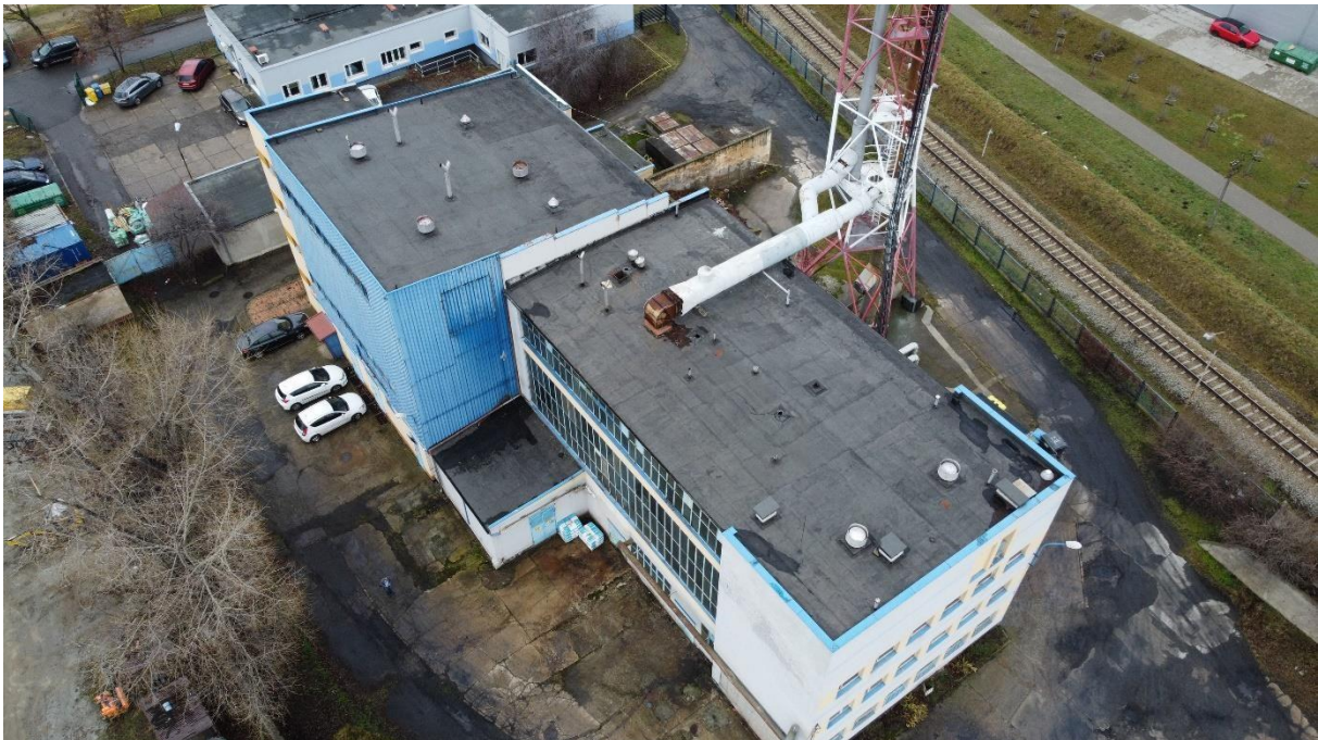
Rysunek 3. Budynek kotłowni – widok z góry
