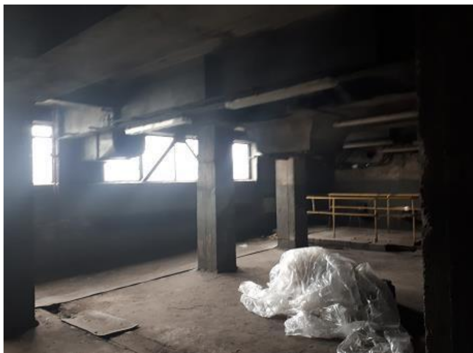
Rysunek 12. Budynek istniejącej kotłowni węglowej- poziom odzuzłania
