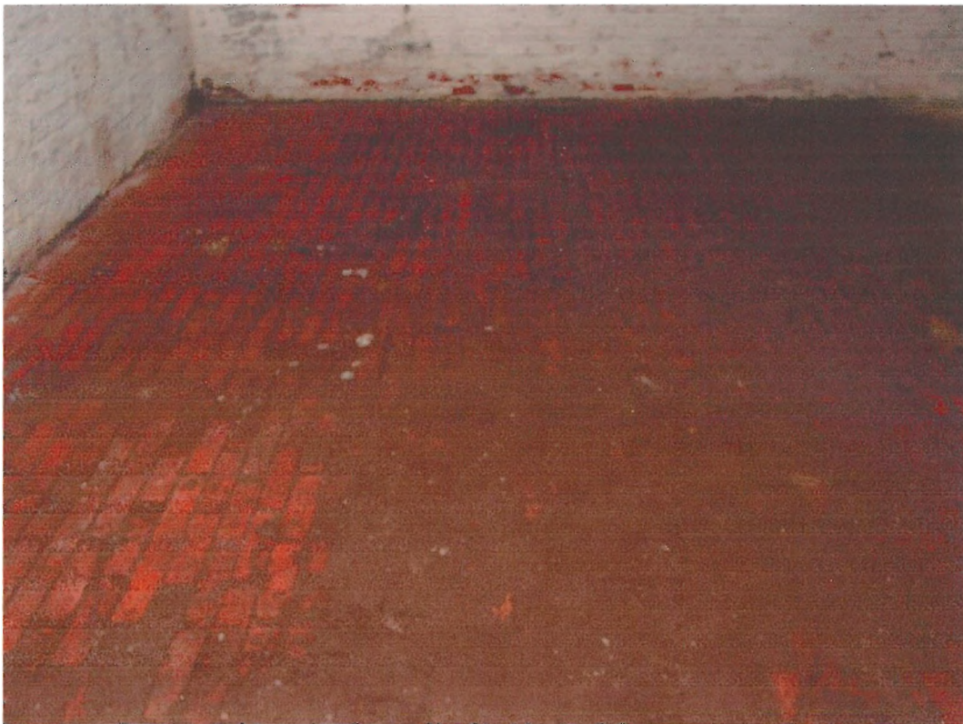
Zdj. 10 Posadzka w kazamatach Bastionu Ostroróg. Cegła położona na rąb sugeruje przystosowanie pomieszczenia do składowania przedmiotów o znacznej masie
