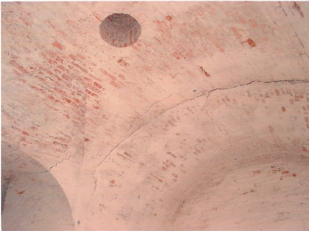
Zdj. 11 Spękania sklepienia kazamat od strony Muru Fosbrei Północnego
