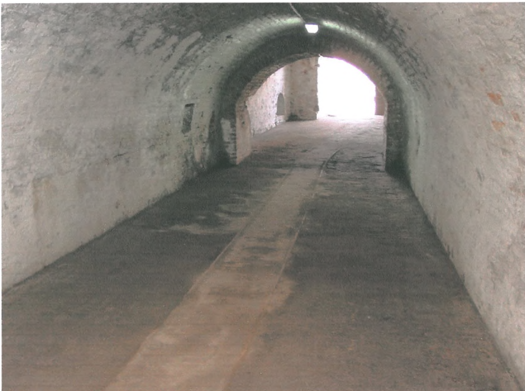
Zdj. 8 Wejście do pomieszczeń Bastionu Ostroróg
