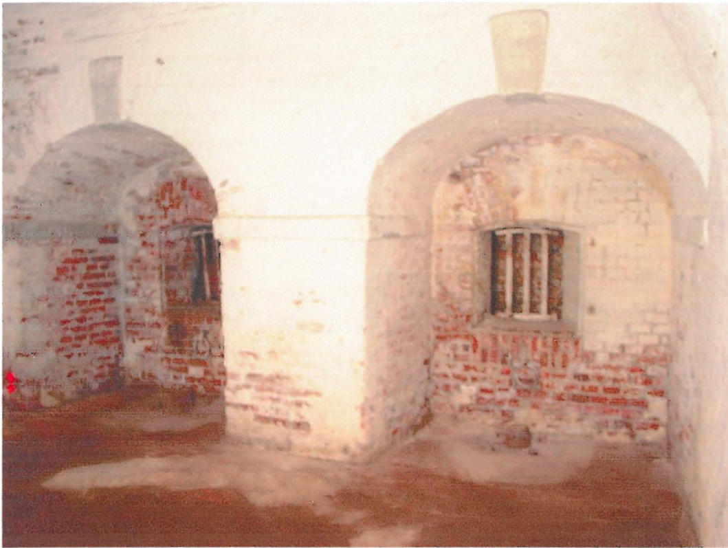
Zdj. 9 Wnętrze kazamat od strony Muru Kurtynowego Wschodniego
