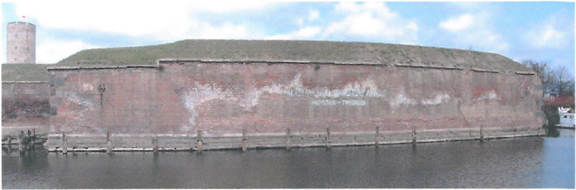
Fot. 3 Widok ściany wschodniej bastionu
