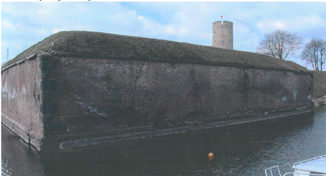
Fot. 1 Widok na ścianę północną Bastionu Ostroróg
