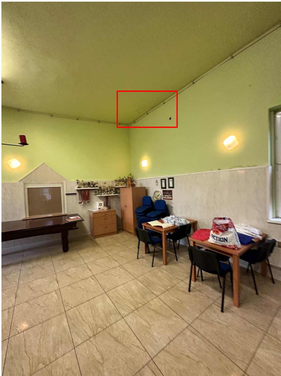
Zdjęcie 24. Nacieki zaobserwowane na suficie w sali głównej świetlicy
