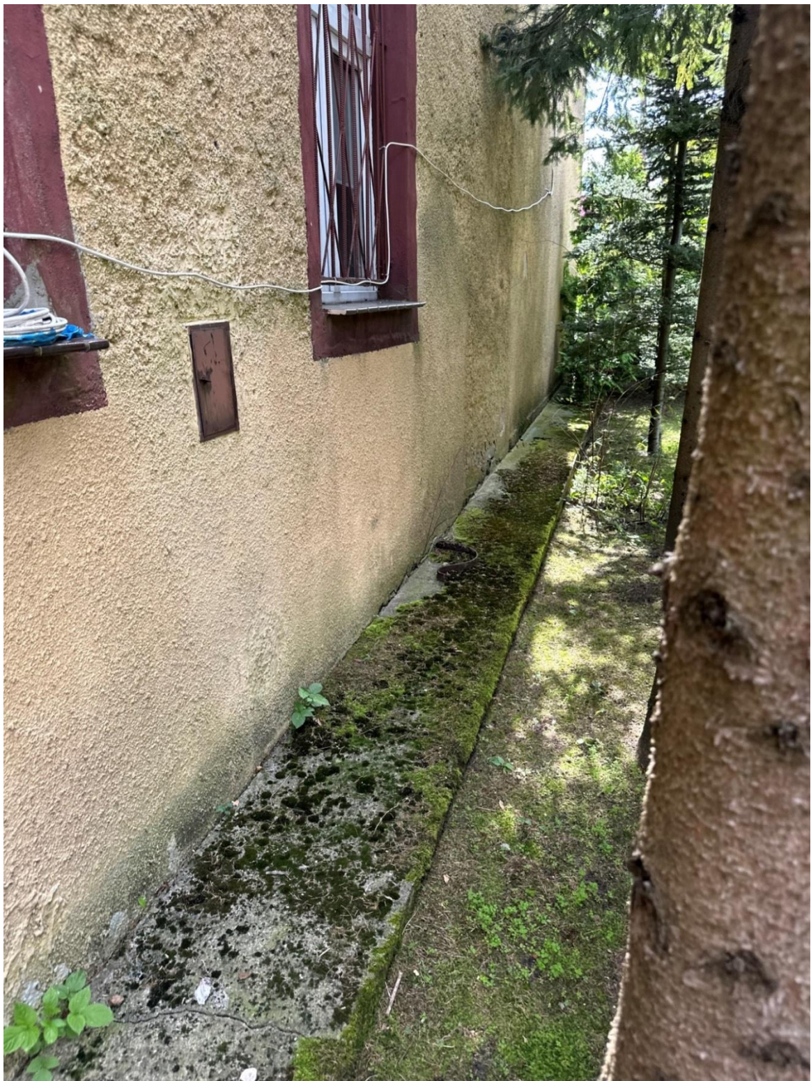
Zdjęcie 20. Widok na znaczne zabrudzenie na elewacji ok. 15 cm od podłoża, wskazujące na zawilgocenie fundamentów
