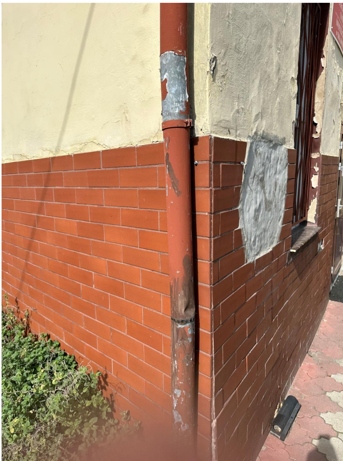
Zdjęcie 17. Zniszczona i nieszczelna rura spustowa
