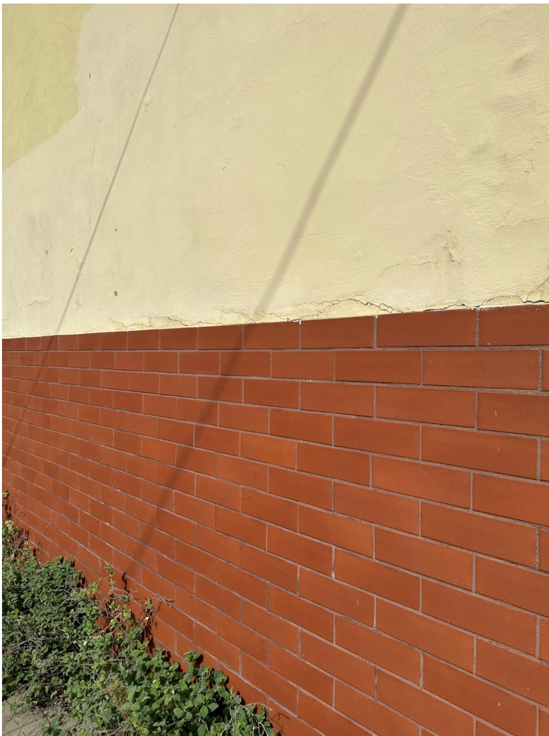
Zdjęcie 19. Spękanie poziome tynku widoczne w miejscu połączenia materiału z klinkierem
