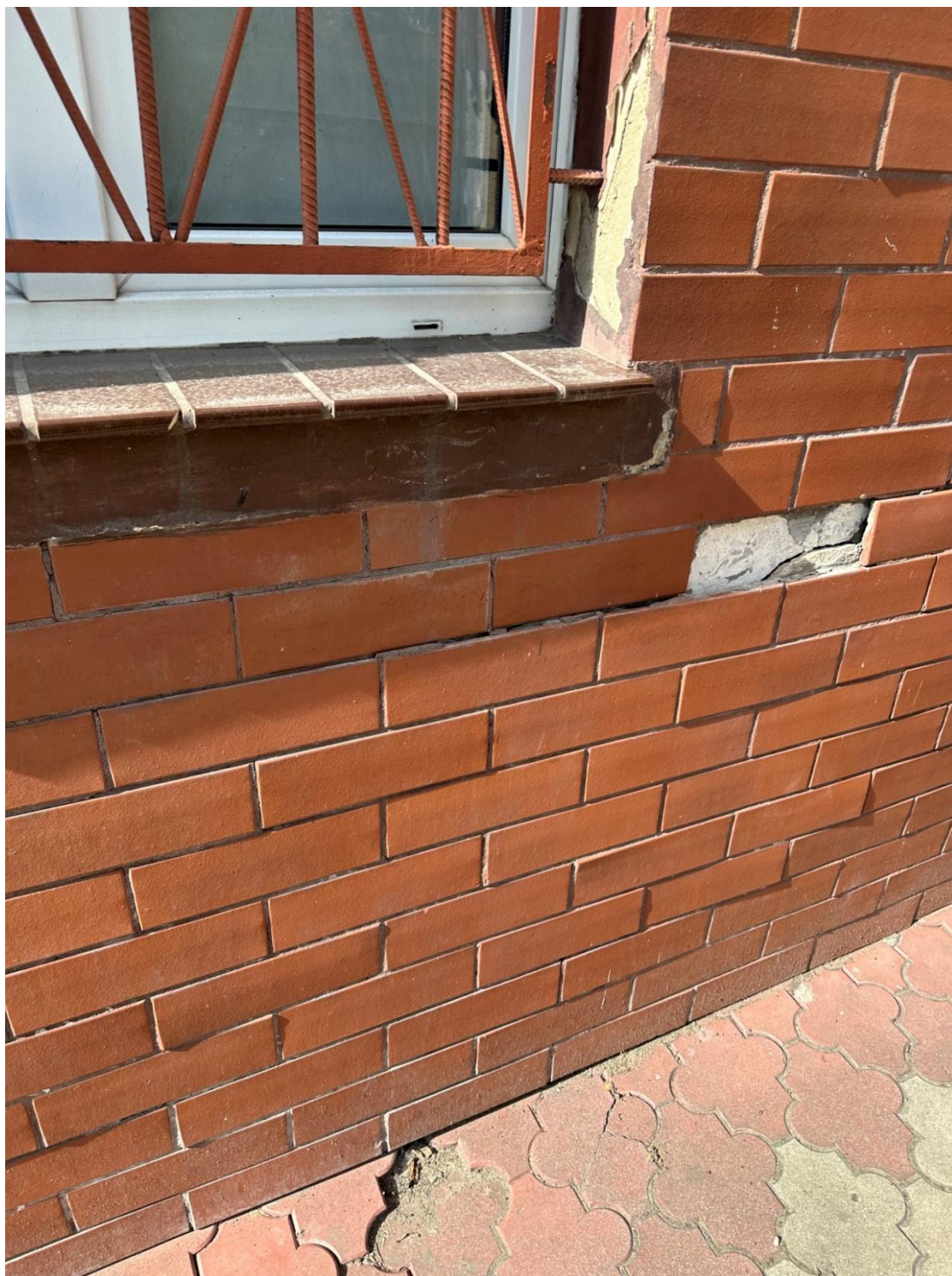
Zdjęcie 15. Nierówności widoczne na powierzchni ściany wykończonej klinkierem, ubytki w wykończeniu
