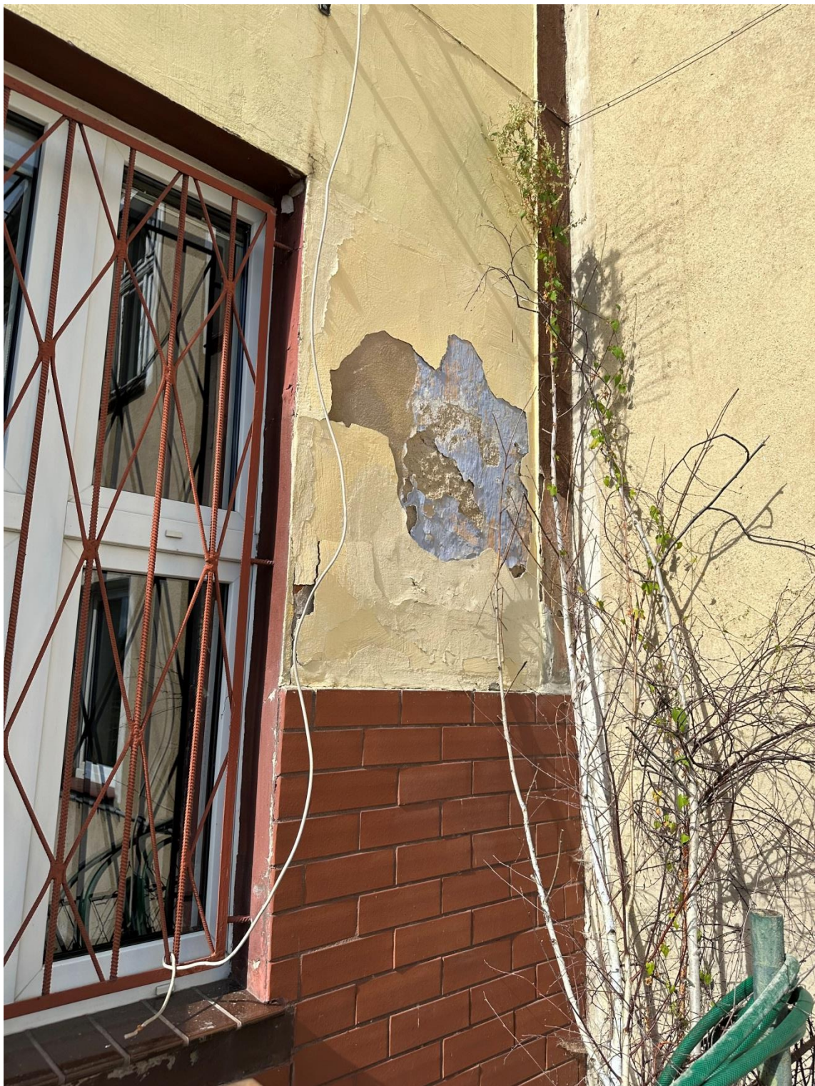
Zdjęcie 16. Odspojenia tynku na elewacji południowo-wschodniej
