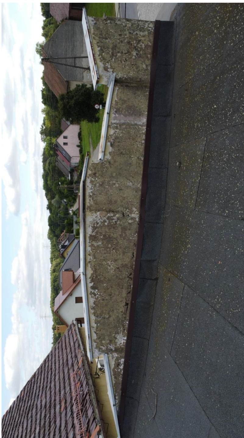
Zdjęcie 8. Attyka na dachu nad częścią sklepową- widoczne spękania, nacieki, zabrudzenia i niewielkie pozostałości tynku
