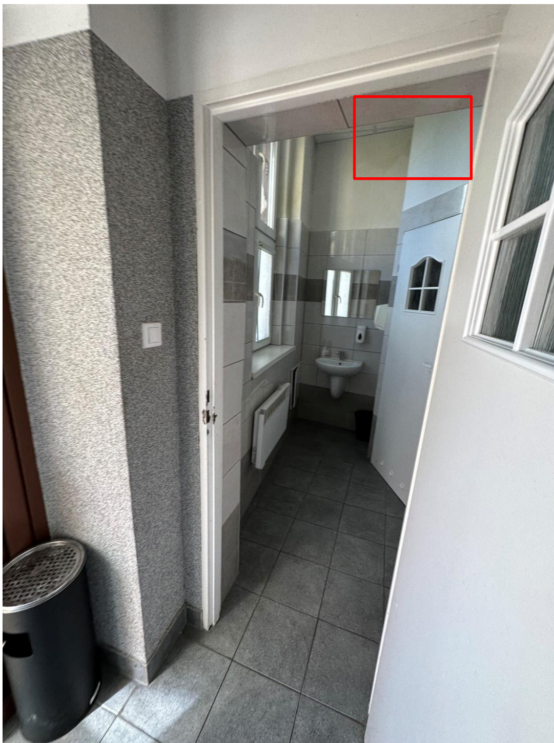
Zdjęcie 27. Naciek na ścianie i suficie w pomieszczeniach sanitarnych
