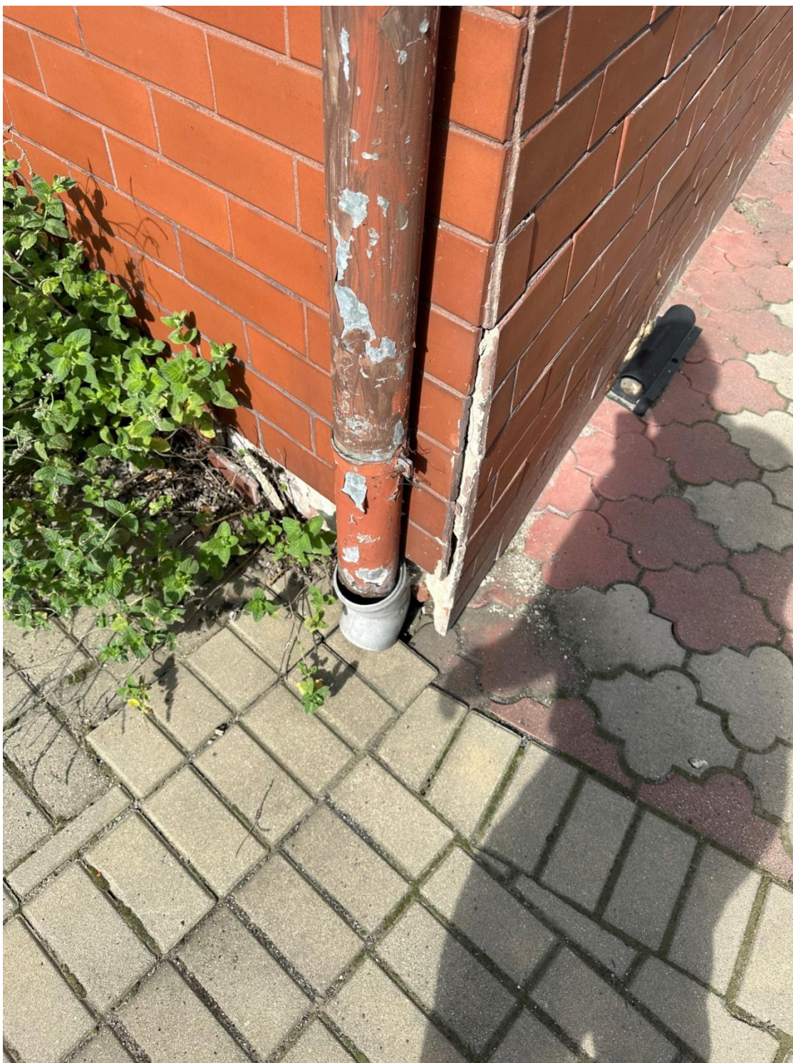
Zdjęcie 18. Widok na przerwę w spoinie łączącej wykończenie ścian oraz zniszczoną rurę spustową
