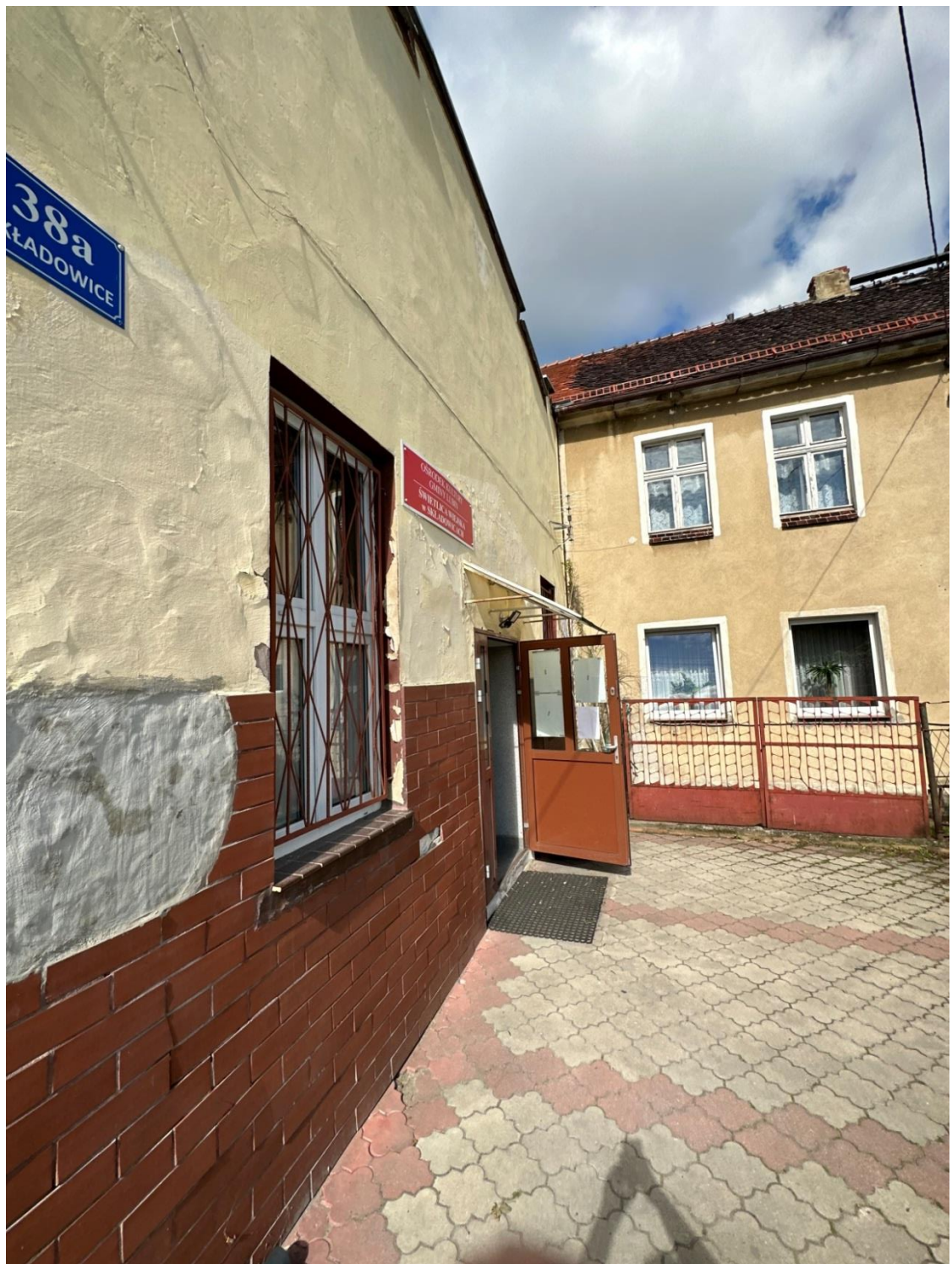
Zdjęcie 11. Ubytki klinkieru na elewacji
