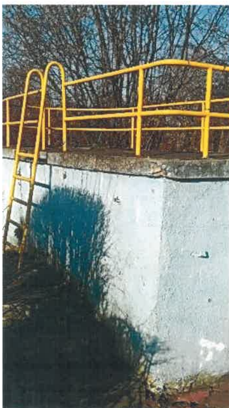
Stanowisko dla ratownika
