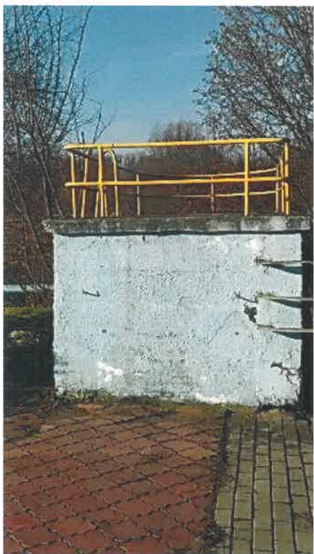
Stanowisko dla ratownika
