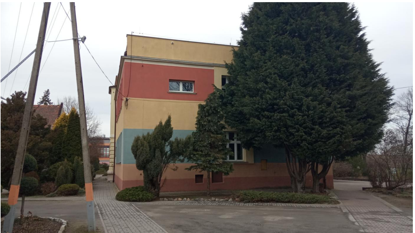
fot. 2 - elewacja wschodnia
