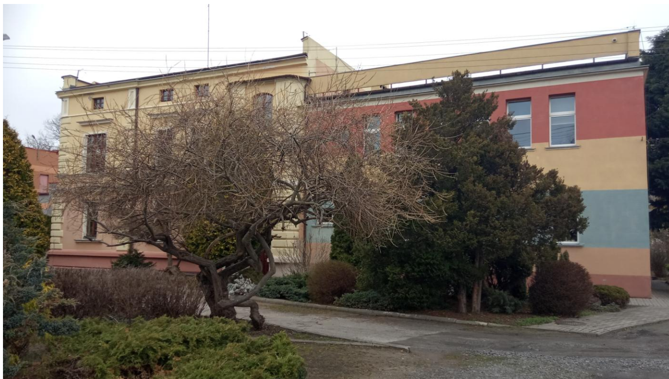
fot. 3 - elewacja południowa
