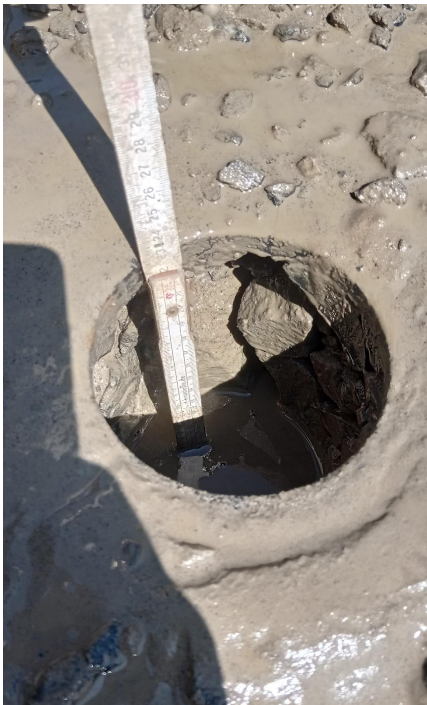
Fot. 3. Konstrukcja istniejącej nawierzchni drogi przy otworze nr 12
