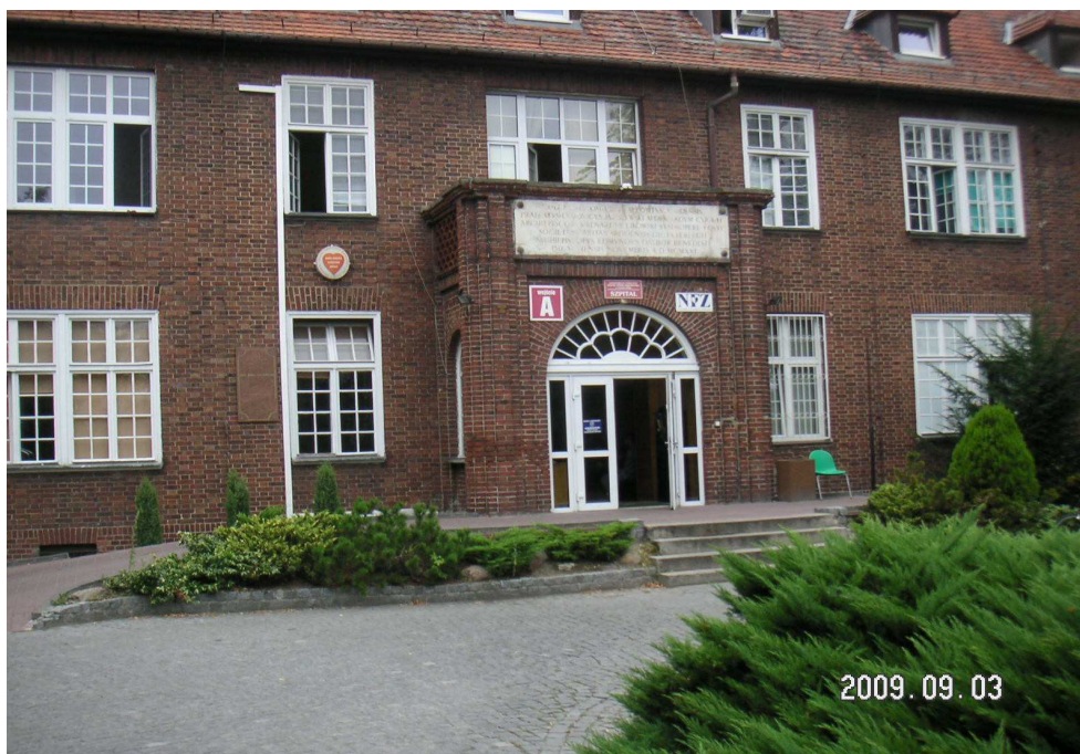
Fragment elewacji budynku Szpitala Powiatowego w Śródzie Wlkp. od strony głównego wejścia „A”.
