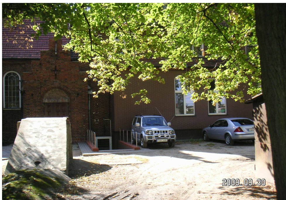
Fragment elewacji budynku Szpitala Powiatowego w Środzie Wlkp. od strony ul. Szarytek z widocznym bezpośrednim wejściem do piwnicy.
