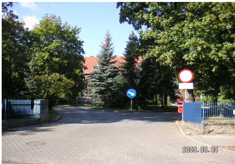
Dojazd pożarowy na teren Szpitala od ul. Żwirki i Wigury. Widoczna na zdjęciu brama posiada szerokość około 7,0 m.
