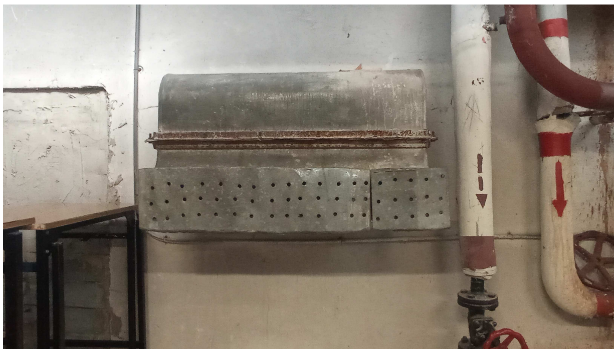
Fot. 2 Wentylacja grawitacyjna nawiewna pomieszczenia węzła
