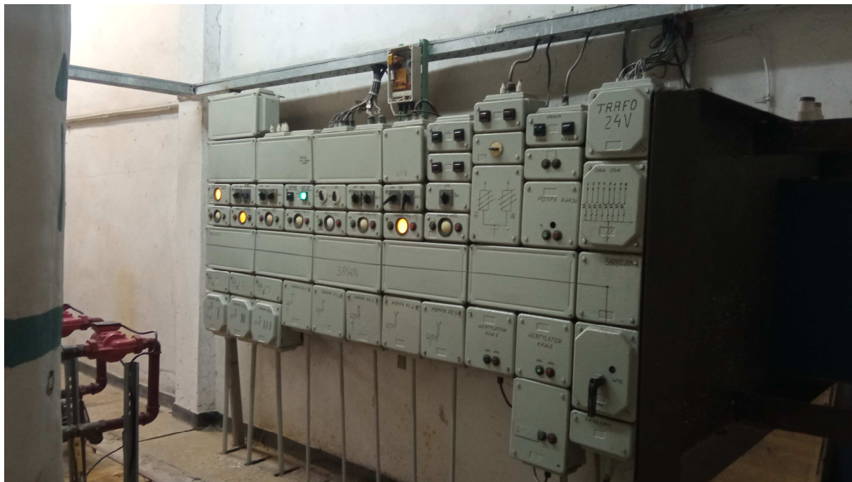
Fot. 6 Szafa elektryczna węzła cieplnego
