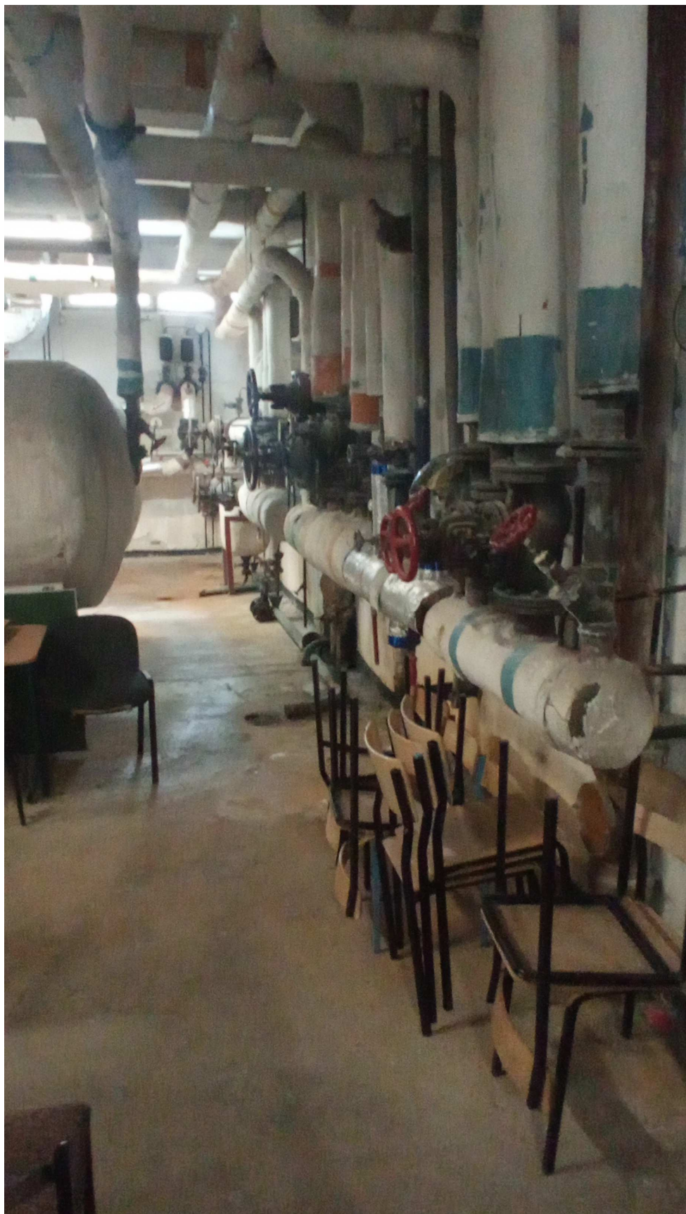
Fot. 5 Rozdzielacze instalacji c.o.
