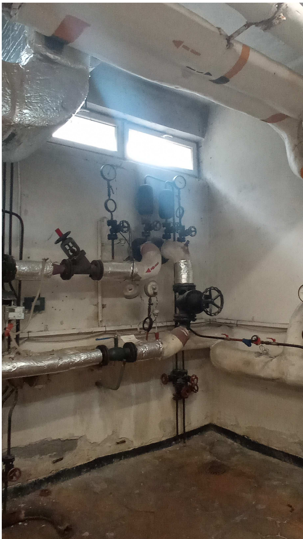
Fot. 1 Wejście przyłącza ciepłowniczego do pomieszczenia węzła
