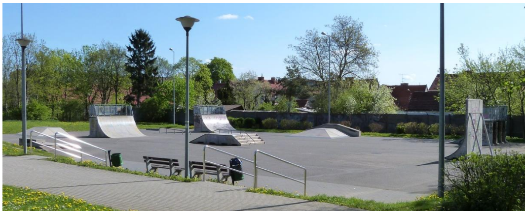
Zdjęcie urządzeń przed demontażem
