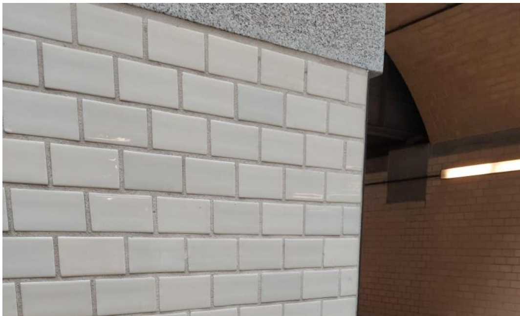
Okładzina ścienna z cegły licowej, szklwionej
