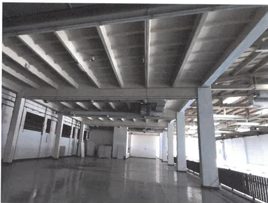
Rysunek 2 Istniejąca konstrukcja prefabrykowana żelbetowa - widok z antresoli, która docelowo będzie stanowić I piętro części biurowo-usługowej.
