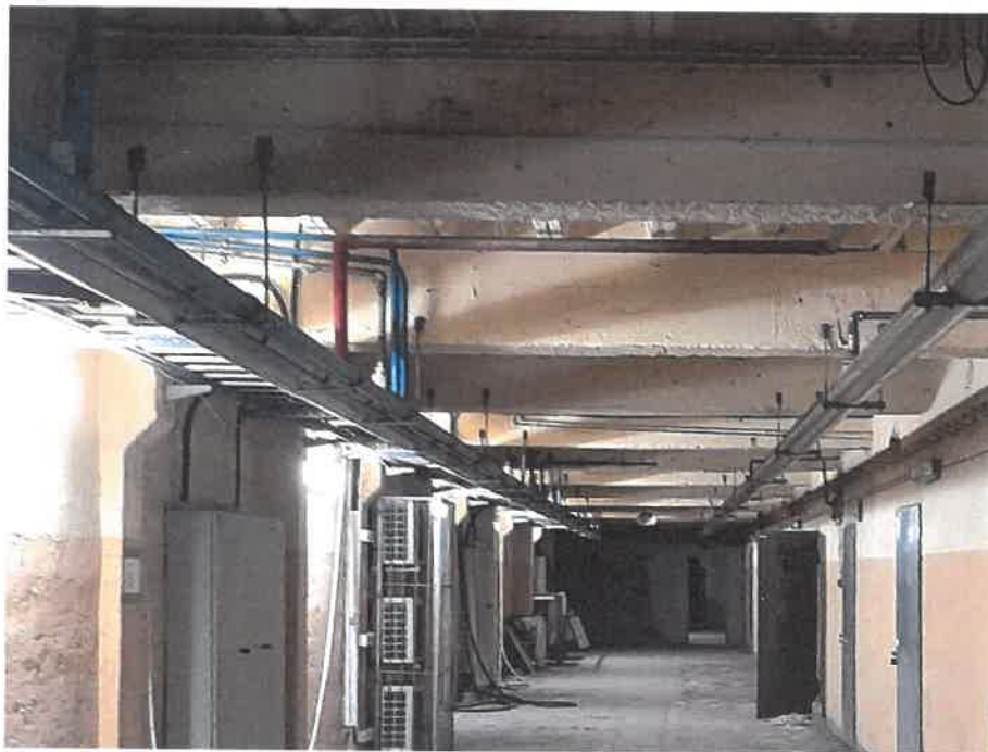
Rysunek 3 Istniejący prefabrykowany strop żelbetowy nad piwnicą.
