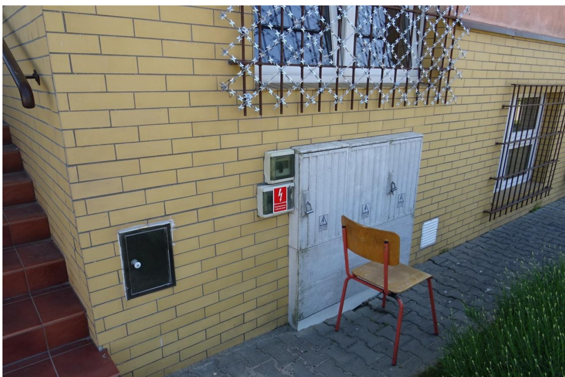
Fot. 2 kablowe złącza zasilające przy budynku
