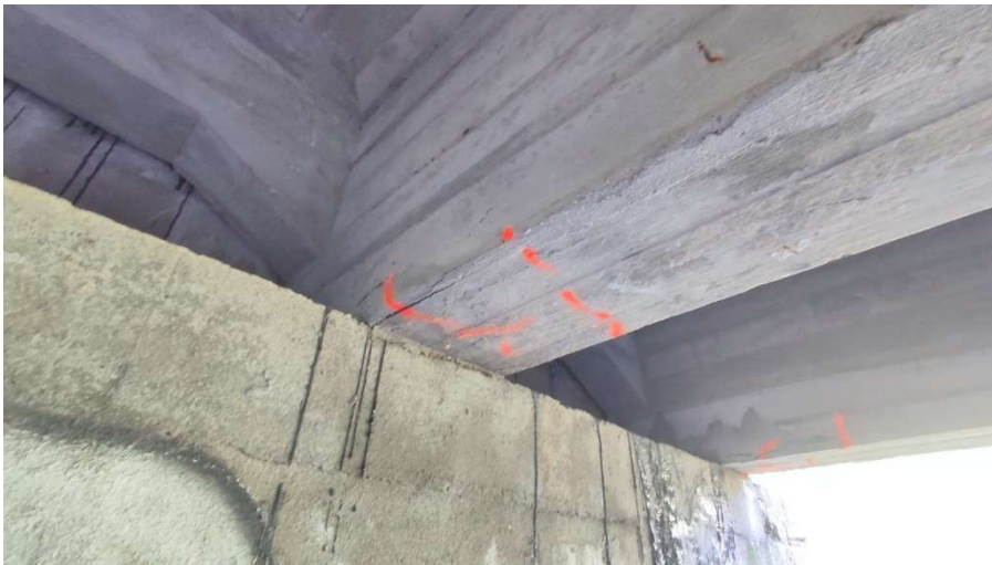
Fot nr. 9 Widok dźwigara w strefie podparcia od strony Chojnic.
