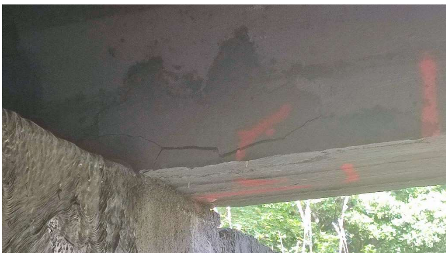
Fot nr. 7 Widok dźwigara w strefie podparcia od strony Chojnic
