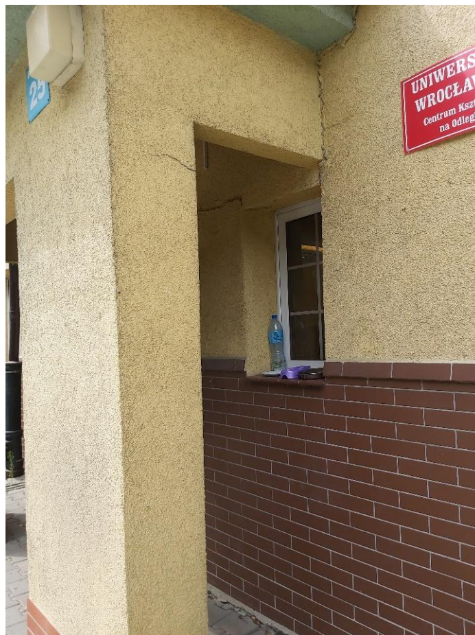
Pęknięcia w strefie łączenia ściany z naprzem ganku
