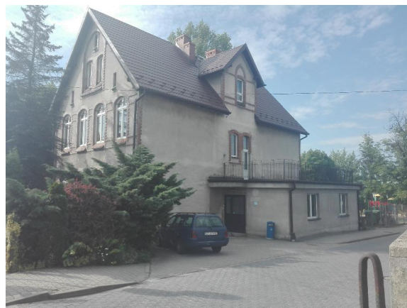
Fot.6 Elewacja północno-zachodnia
