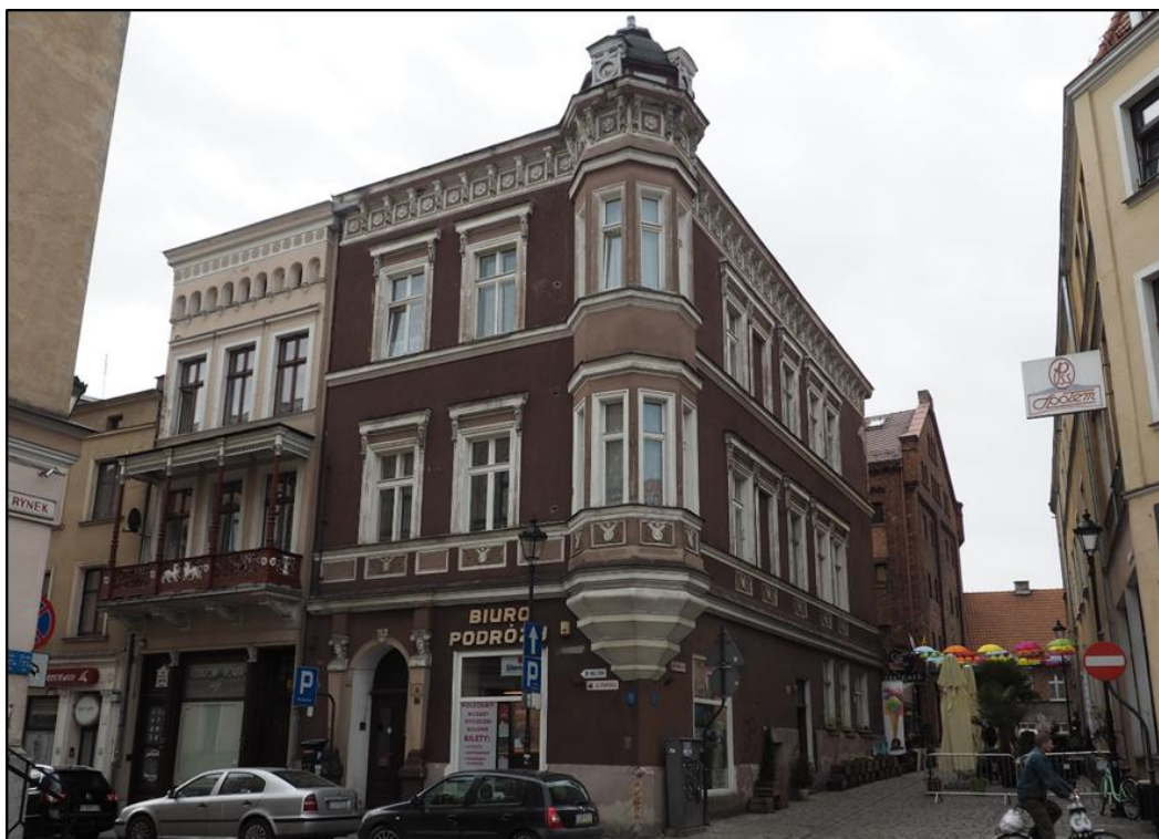
Fot nr 1. Widok na cały budynek od strony Ryunku Gł. Stan ogólny.
