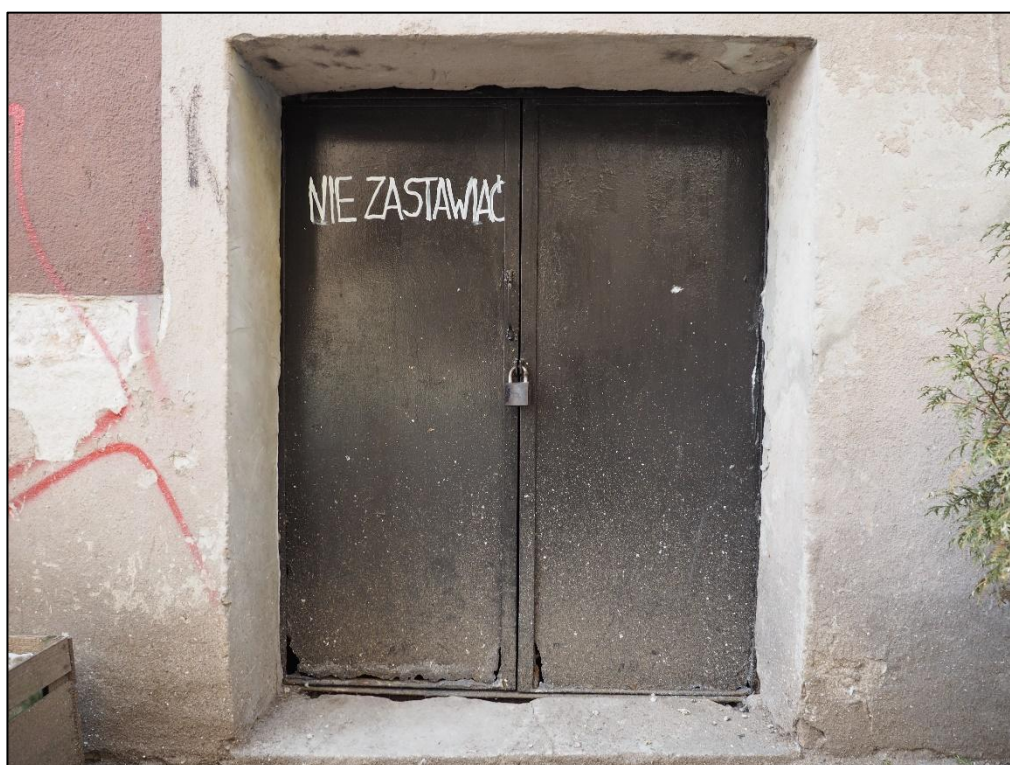
Fot. nr 14. Otwór wejściowy do piwnic od ul. Reja- drzwi metalowe dwuskrzydłowe.
