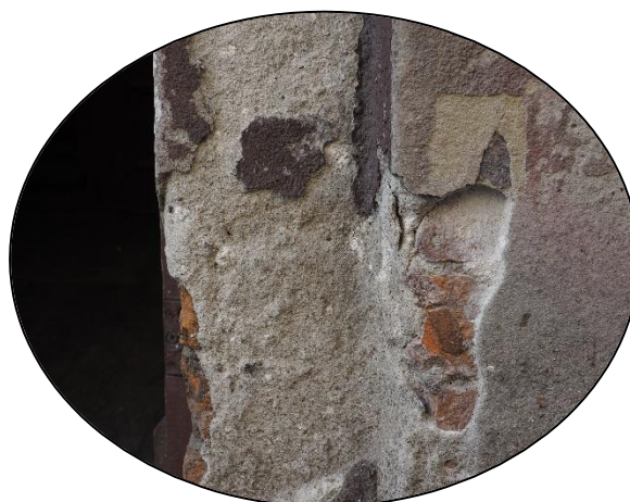
Fragment cokołu (od ul. Reja) z widocznymi dwoma warstwami tynku i zacierką . Na zachowanym wcześniejszym tynku. widoczne pozostałości szarej warstwy malarskiej.
