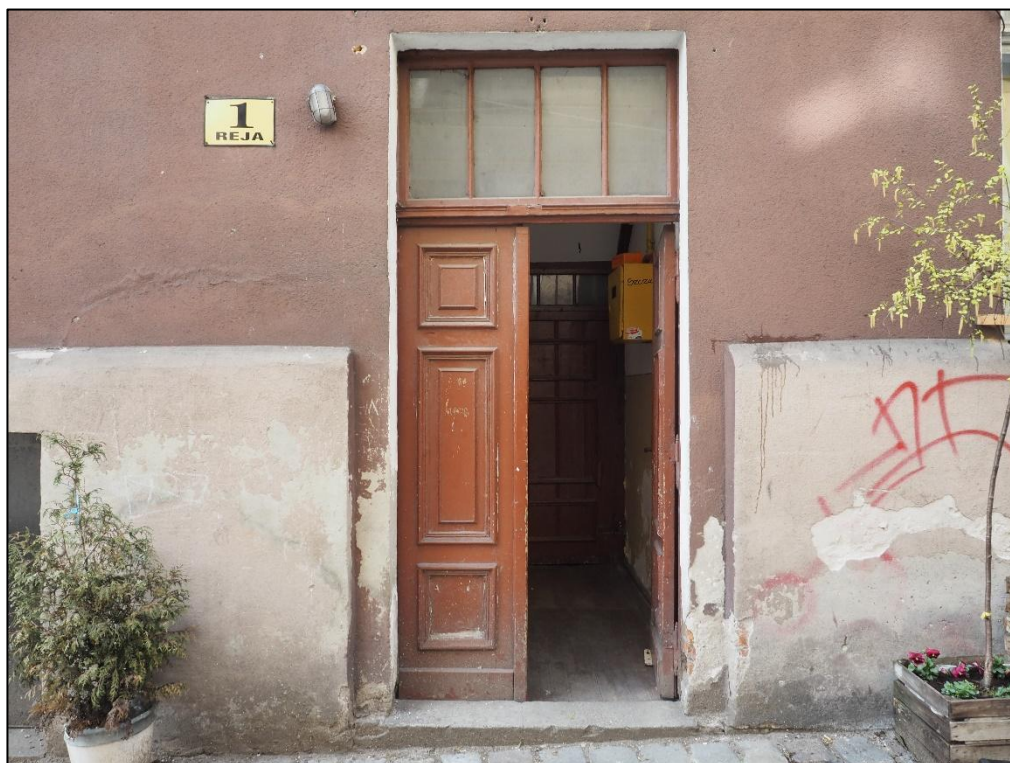
Fot. nr 13. Otwór wejściowy od ul. Reja- drzwi ramowo-płycinowe z nadświetlem.
