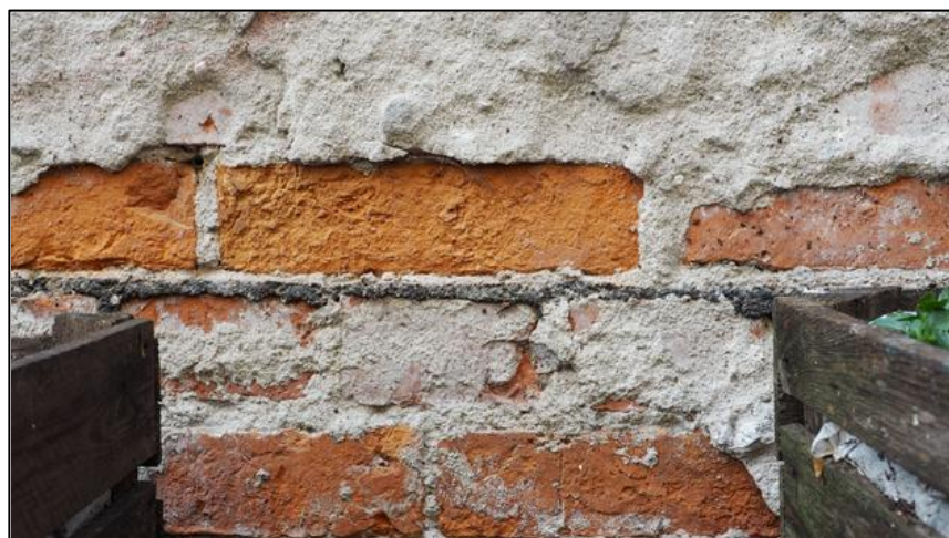
Widoczna izolacja pozioma-papa bitumiczna powyżej 8 warstwy cegły muru powyżej gruntu.
