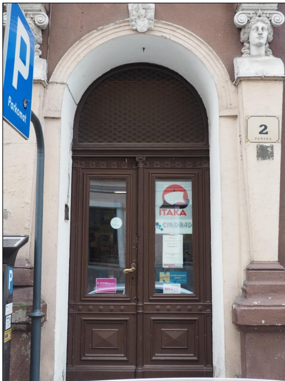
Fot. nr 12. Otwór wejściowy główny od ul. Pańskiej - drzwi ramowo-ptycinowe z nadświetlem w części północnej elewacji.
