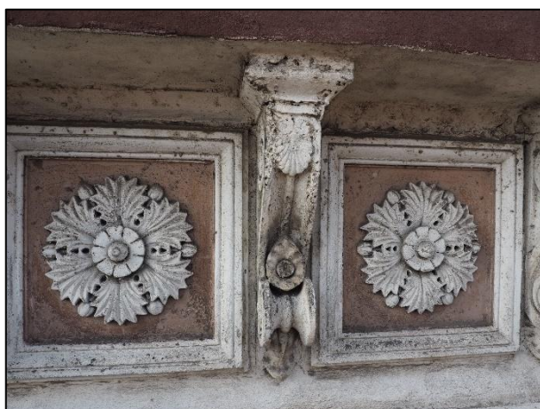
Dekoracje sztukatorskie gzymsu koronacyjnego. Rozety w kwadratowych polach oraz kroksztyny.
