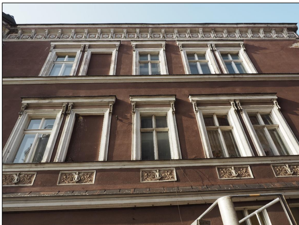
Fot. nr 8. Górne kondygnacje elewacji od. ul Reja. Widoczna stolarka okienna i bogaty detal architektoniczny.
