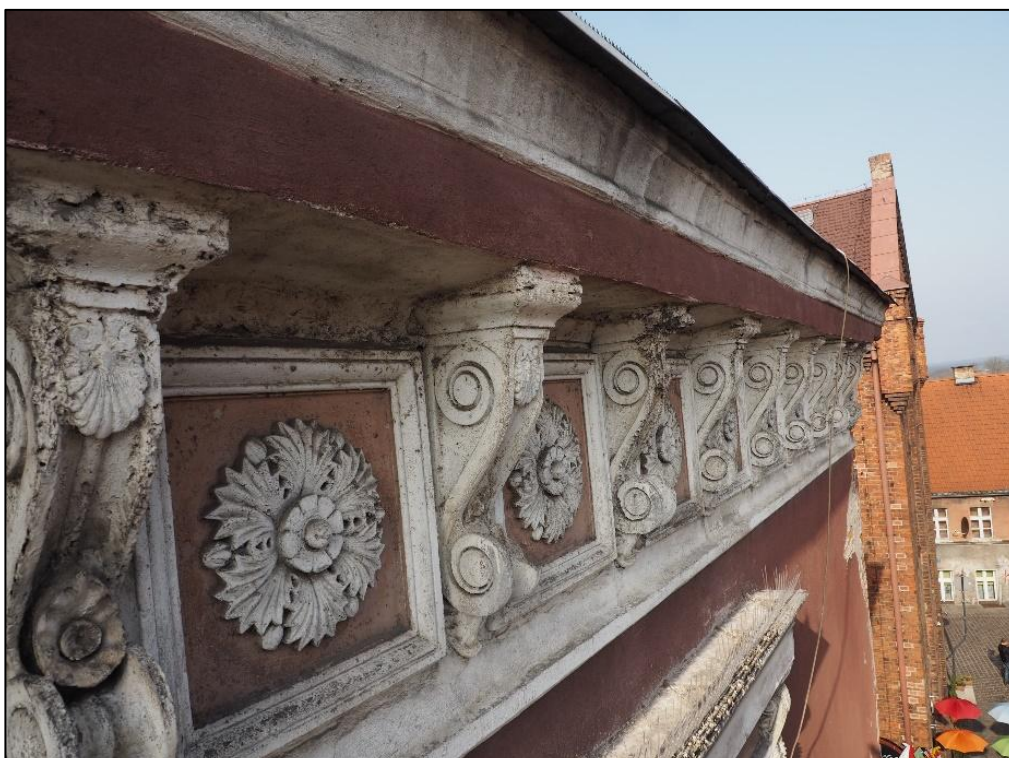
Fot nr 10. Gzyms wieńczący elewację z dekoracyjnym fryzmem złożonym z konsolk i rozet. Widok od ul. Reja.
