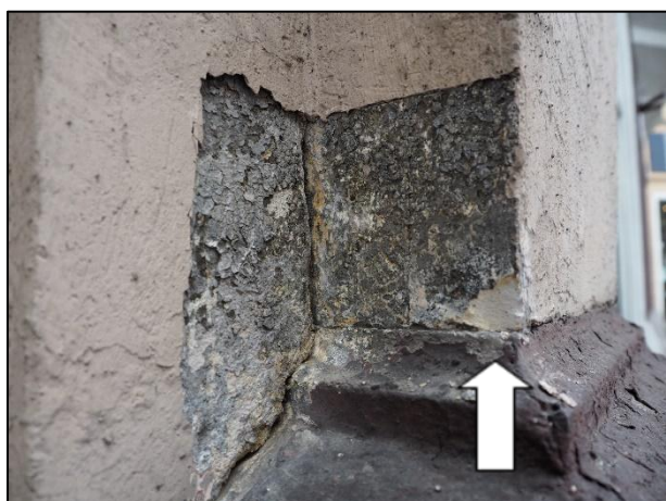
Odkrywka na połączeniu bazy, pilastra i tła portalu z widocznymi nawarstwieniami malarskimi. Obok przekrój poprzeczny zaprawy gipsowej z pilastra z warstwami malarskimi na powierzchni.
