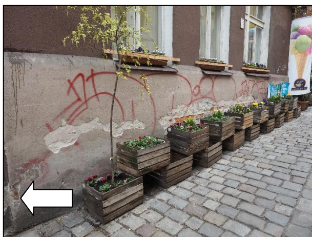
Fragment cokołu (od ul. Reja) z widocznymi dwoma warstwami tynku i zacierką . Na zachowanym wcześniejszym tynku. widoczne pozostałości szarej warstwy malarskiej.
