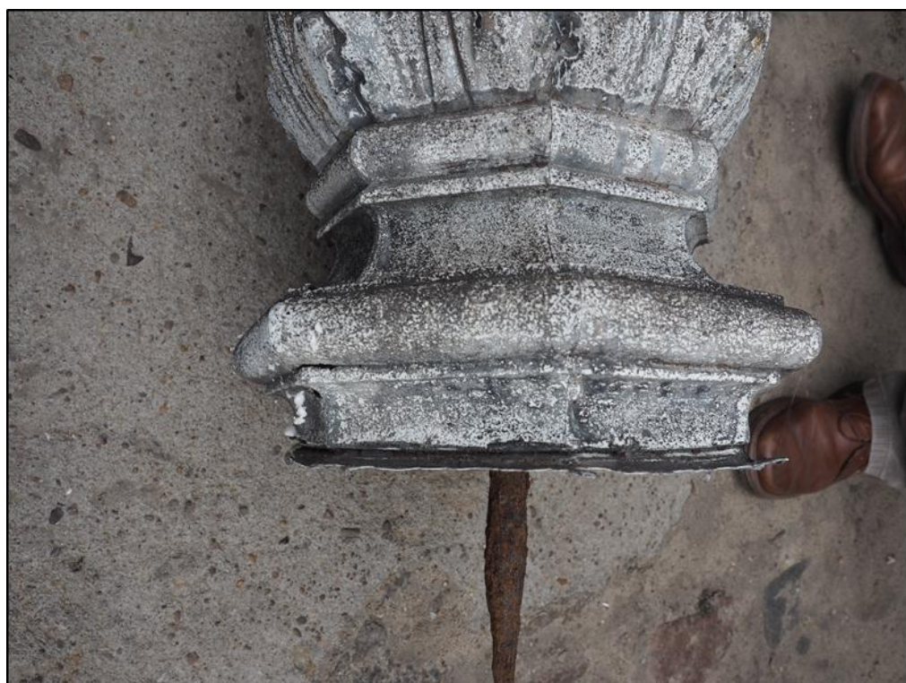
Fot. nr 18. Zdemontowana iglica ze zwieńczenia wykusza. Widok na bazę elementu, która ze względu na większą grubość blachy, zachowana jest najlepiej.
