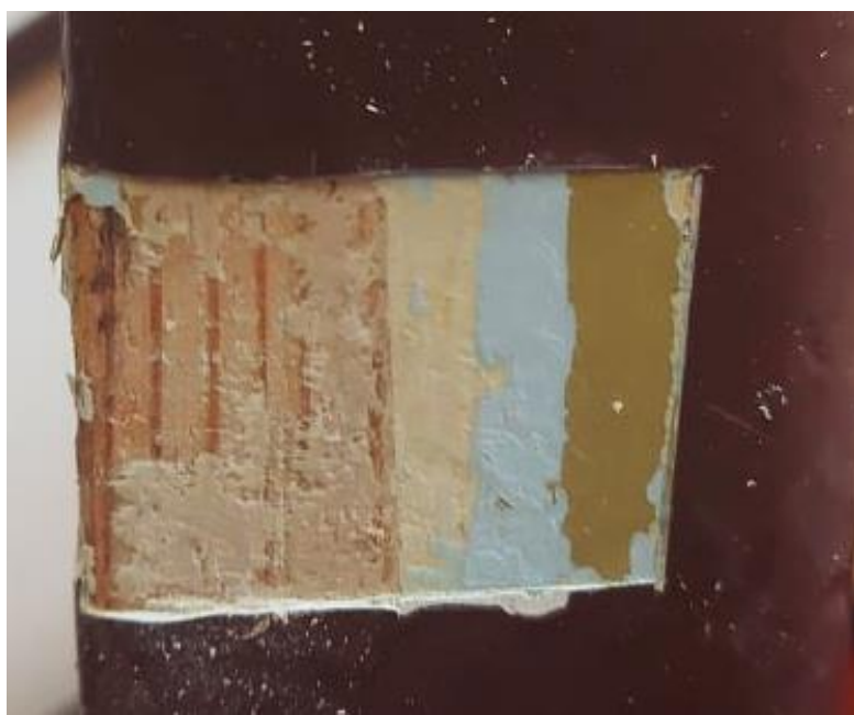
Odkrywka nr K.4. – balustrada, słupek
