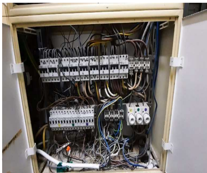
Opis: W pomieszczeniu rozdzielni głównej budynku znajdują się rozdzielnice pozbawione osłon wykonanych z nieprzewodzących materiałów w celu ochrony przed porażeniem. Przewody i zaciski pod napięciem bez jakiegokolwiek osłony. Ryzyko porażenia prądem.
