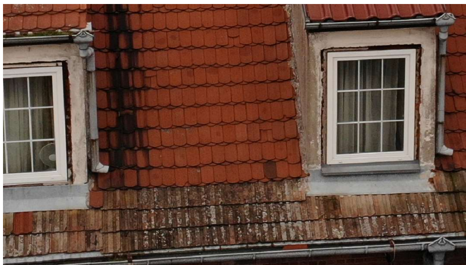
Fot. 8 Widok stanu rynien, rur spustowych i obróbek blacharskich wykonany z nalogu dronem.
